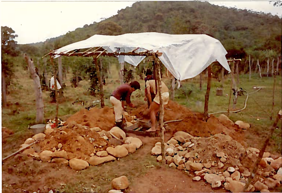
Foto 03 - Escavação dos poços de pesquisa. O material amostrado é depositado numa "praça" aberta em torno dos poços. Ao fundo vê-se a bomba hidráulica que faz o escoamento dos poços.
