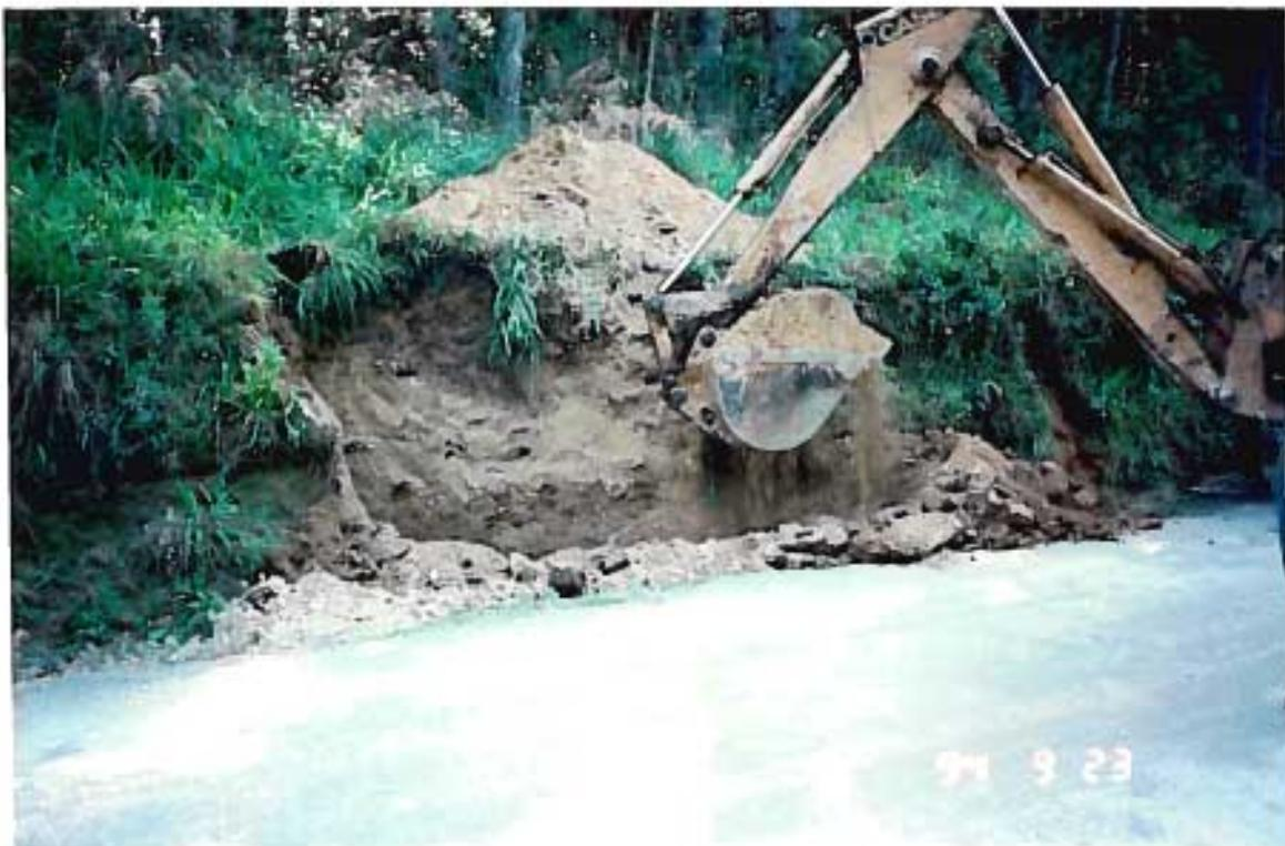
**Foto 06 - Ocorrência AC-537. Abertura com a retro-escavadeira, observando-se o modo de ocorrência em pequena elevação e profundidade de 5 metros.**
