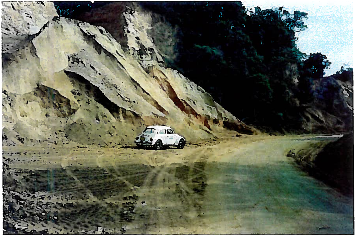
Foto 15: Alteração do granito Três Córregos, junto á Estrada do Cerne , muito utilizado para revestimento das estradas locais.
