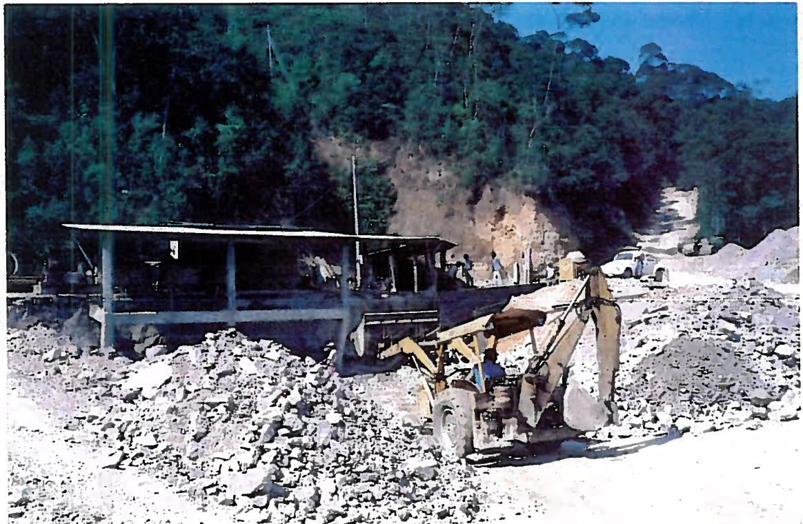
Foto 08: Vista geral da retirada de minério aurífero das galerias, pela mineração Tabiporã Ltda., na localidade de Povinho.
