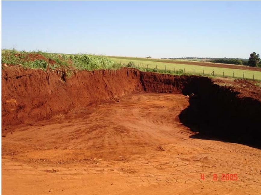
Foto 13 - Célula pronta para receber lixo no aterro sanitário.(sem manta de impermeabilização)
