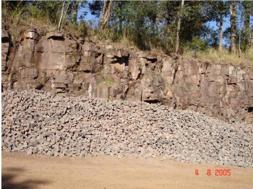
Foto 19 - Em primeiro plano os blocos utilizados em calçamento com pedras irregulares
