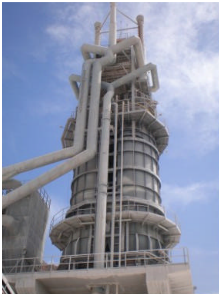
Figura 05 – Forno de Cal Cimprogetti – Two D – Multicombustível, capacidade de 400 t/dia de Cal Virgem
