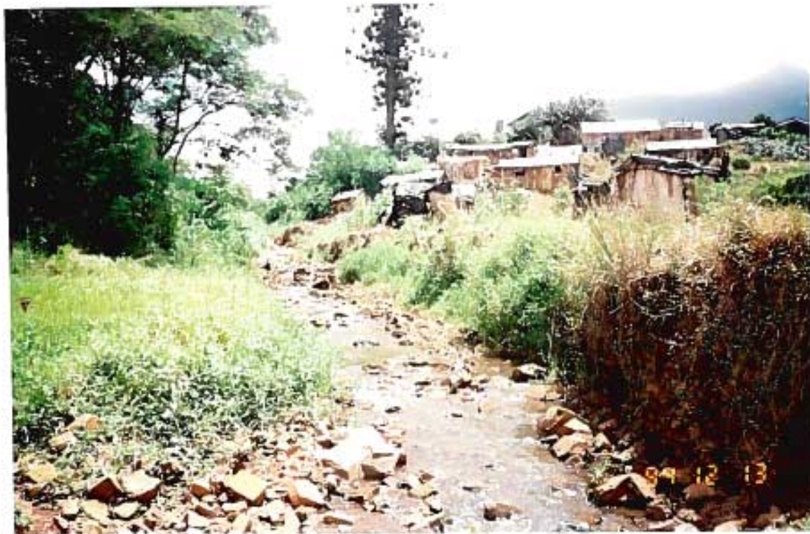
Foto 07 - Habitações irregulares posicionadas nas margens dos rios, sujeitas a constantes inundações devido às chuvas.
