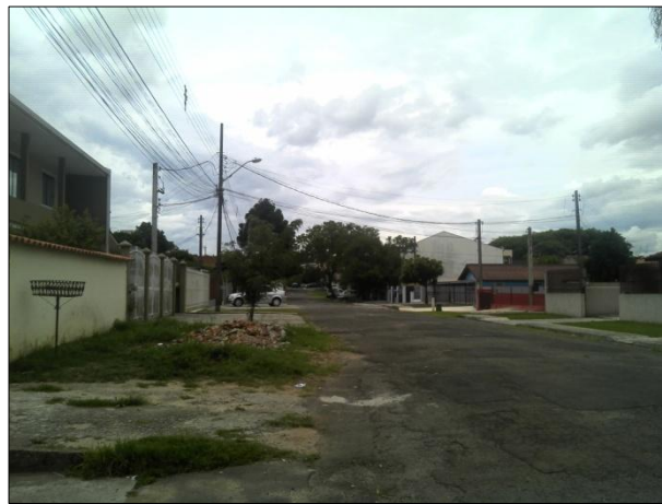
Fotografia 10. Rua Min. José Linhares com GAP (DSC00353).
