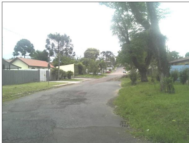
Fotografia 9. Trecho da Rua Sebastião Silva onde é verificada uma "boca de lobo" (DSC00355).
