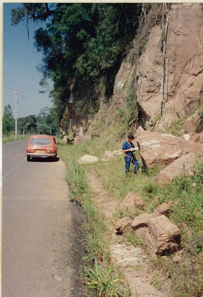
Foto 07 - Blocos de arenito desmoronados a margem da BR-476, a poucos metros da ponte Interventor Manoel Ribas (ponte antiga)
