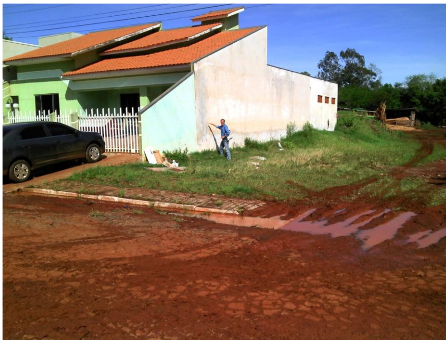
Foto 3 - Vista da área inundada no setor 02 e uma das residências afetadas, em local próximo à ponte sobre o Rio Mato Rico - Av. das Araucárias, nível d'água: 1,40m acima da rua.
