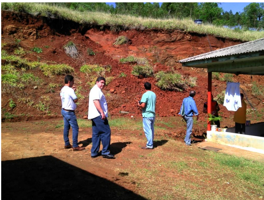
Foto 7 - Aspecto dos cortes da encosta, quedas de solo e rocha alterada e a posição das moradias.
