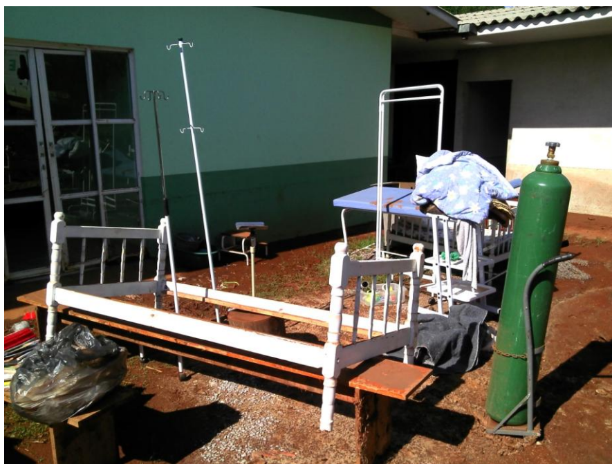
Foto 2 - Materiais danificados do posto de saúde, removidos após o refluxo das águas. Observar o nível marcado nas paredes.
