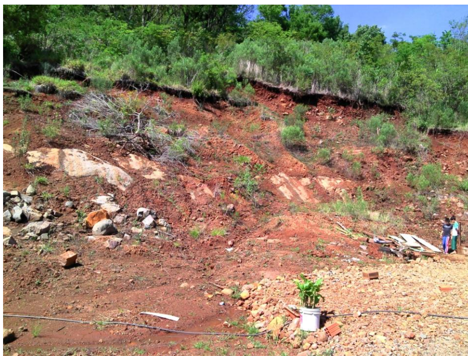
Foto 8 – Continuidade do mesmo setor, com alguns degraus de abatimento na encosta e queda de vegetação.
