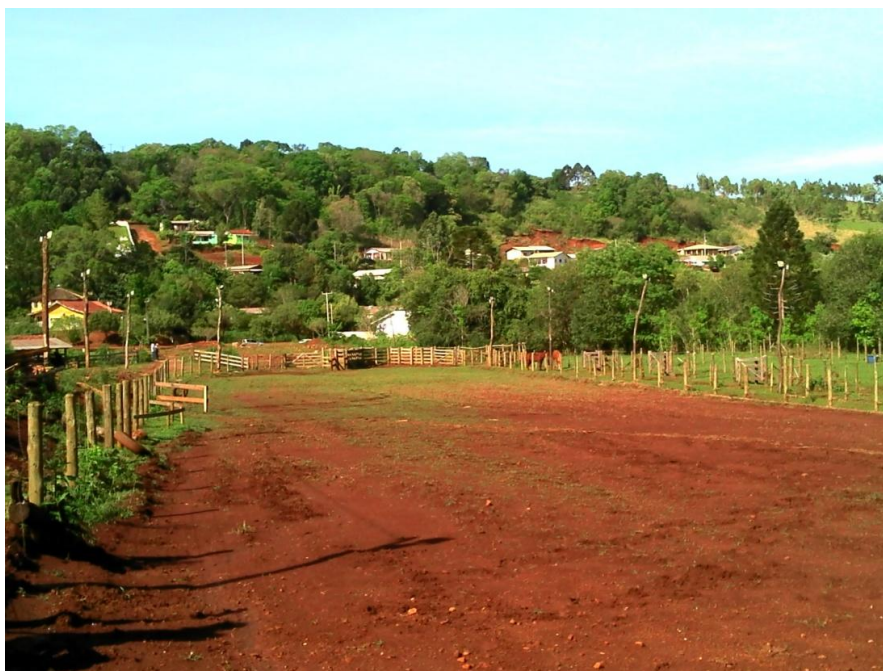
Foto 1 - Vista de parte da área que foi inundada (Setor 01, foto tomada a partir do ponto 01b em direção à Avenida). No meio da encosta são visíveis os cortes onde ocorreram deslizamentos (Setor 03).
