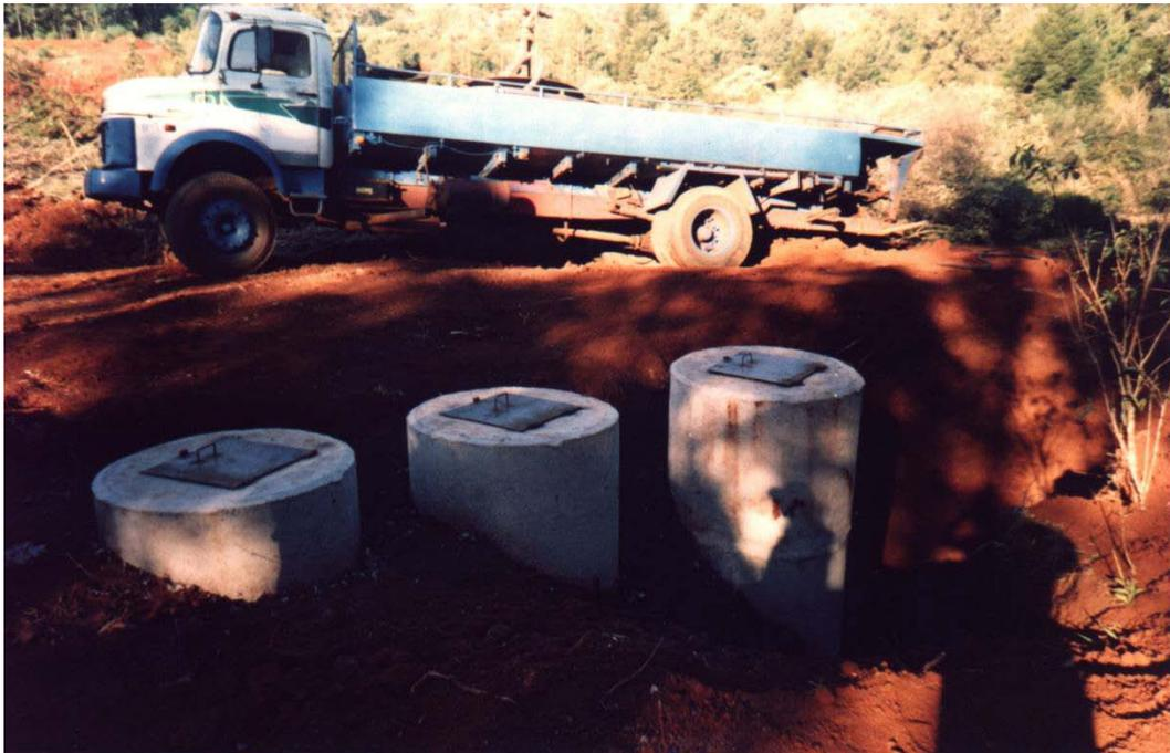
Fig. 6 – Câmaras de concreto para disposição de resíduos hospitalares.
