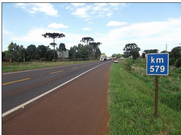
km 579 – vista em direção ao km 578 - vegetação a ser suprimida ao longo da faixa de domínio
