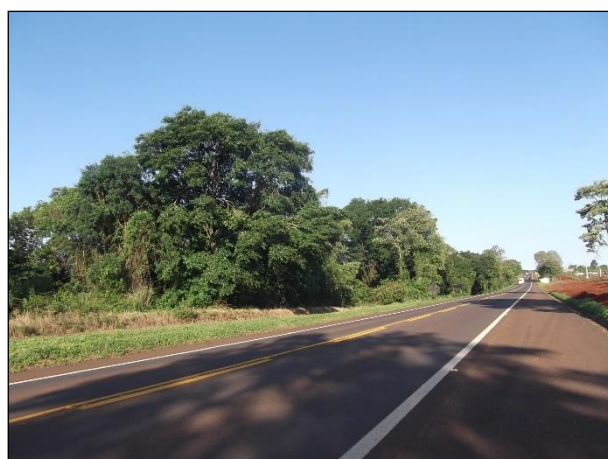
km 575+200 – vegetação a ser suprimida para implantação da trincheira
