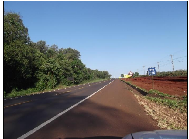
km 575+200 – vegetação a ser suprimida na faixa de domínio para implantação da trincheira
