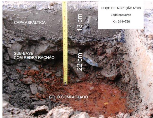
Figura 11 – Pavimento Existente Rodovia BR-277 km 344+720
