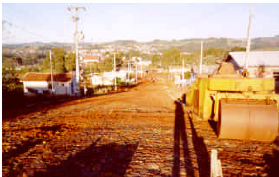
Foto 4. Calçamento de via pública com pedras irregulares em execução, bastante utilizado em Chopinzinho.
