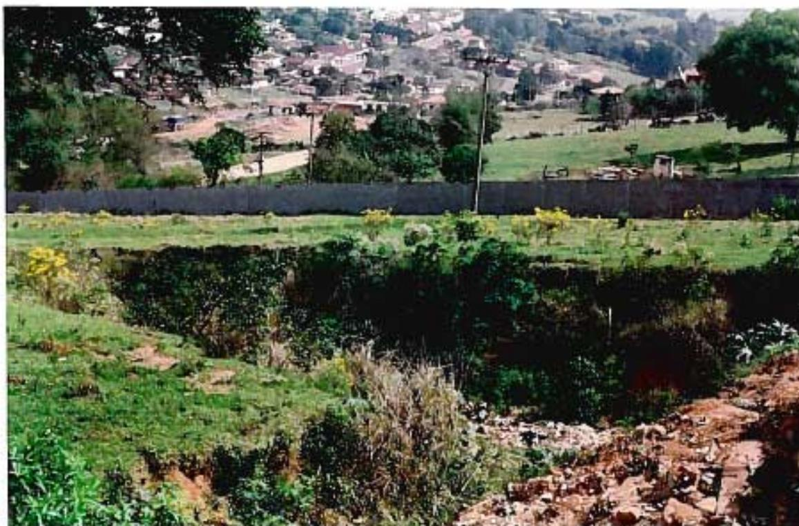
Foto 8 - Tentativa de contenção de processo de boçorocamento com despejo de lixo e entulho em Jacarezinho.
