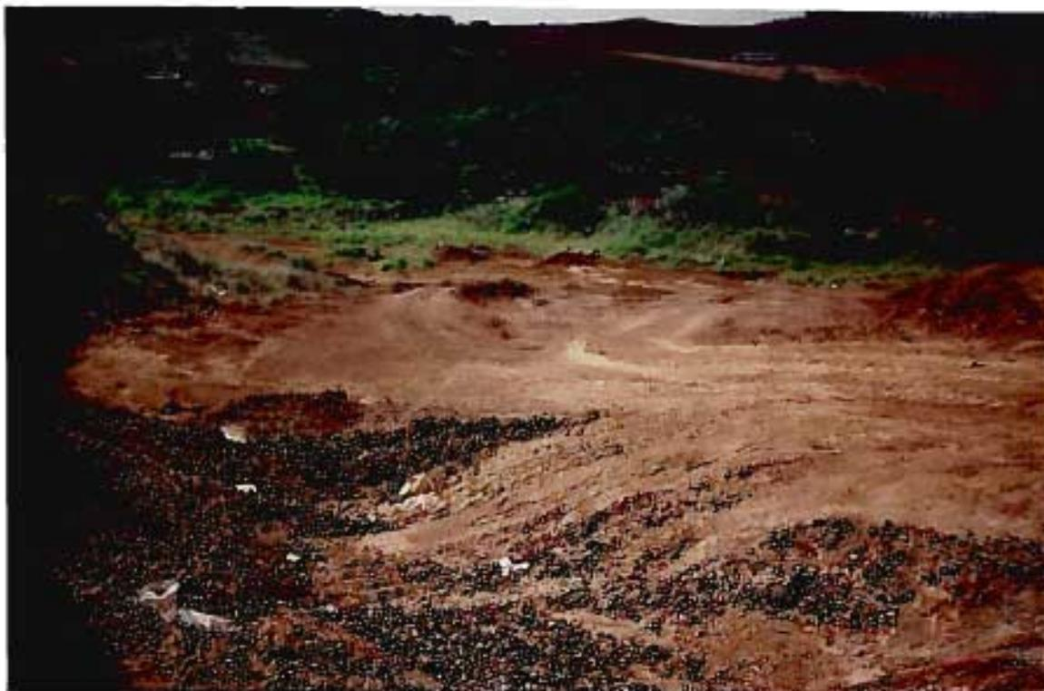
**Foto 12 - Mutilações no terreno provocadas pela retirada de material para revestimento em área suscetível aos fenômenos de instabilidade de encostas.**
