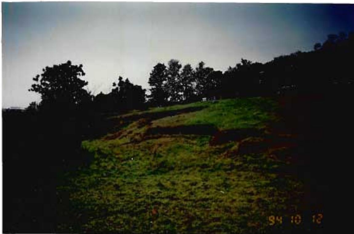
**Foto 11 - Detalhe de desabamentos e colapso do terreno provocados por erosão interna.**
