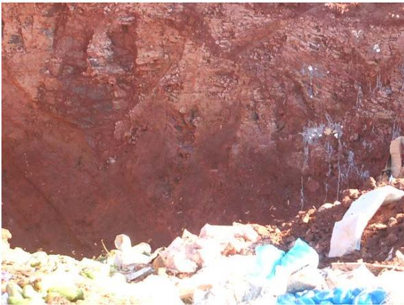
Foto 27 – Lixo depositado diretamente sobre saprolito, sem mantas ou tratamento de chorume.
