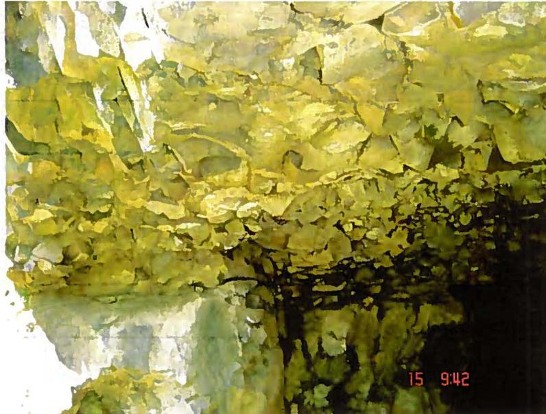
Foto 03 – Ch 05 – Lavra do Flávio, mostra a disposição da laje, basalto maciço, entablado, formando uma verdadeira viga, sustentando a parte superior da galeria.
