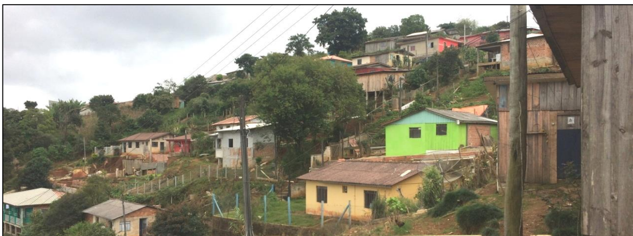
Fotografia 5. Habitações de baixo e médio padrão construtivo no SR avaliado (IMG_0839).
