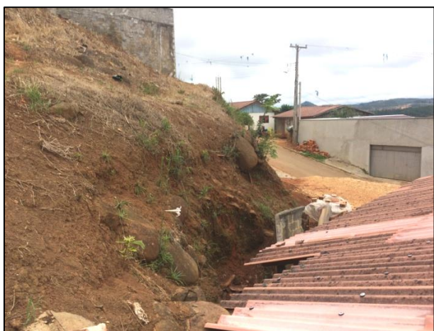
Fotografia 6. Solo de alteração do dique de diabásio no SR (IMG_0835).
