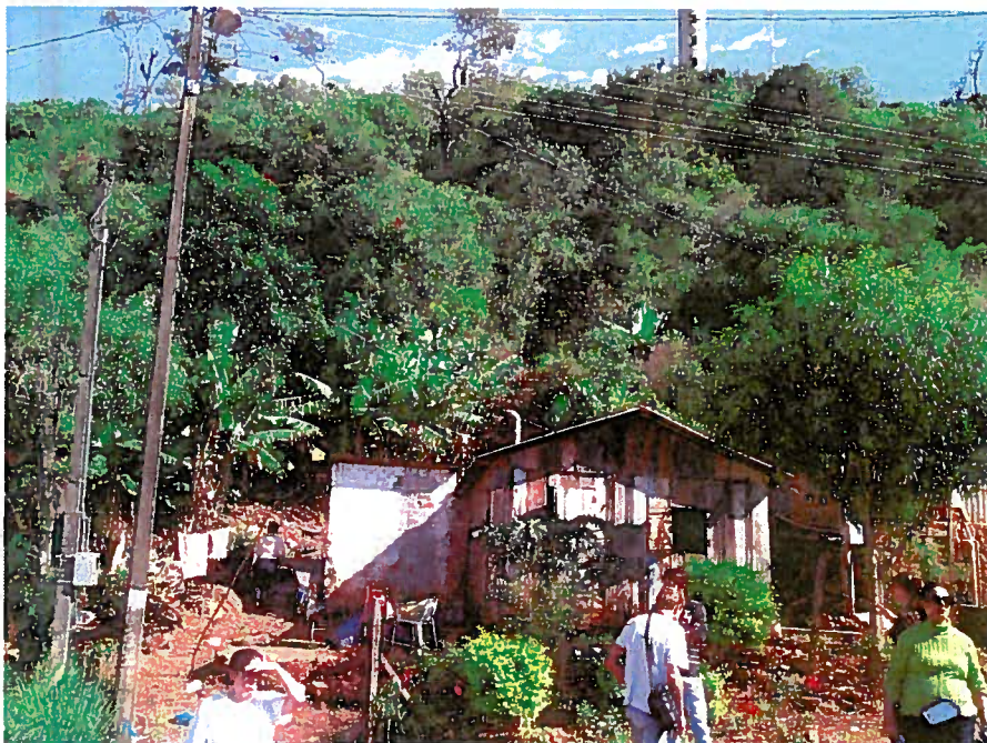
Foto 2. Casa de invasão acima da Rua Cauã, atrás da qual passa a trinca principal da encosta.
