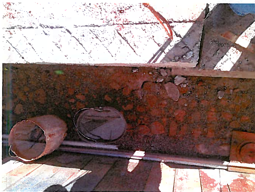
Foto 4. Trinca nas fundações de residência abaixo da Rua Cauã, reflexo da trinca aberta no terreno.
