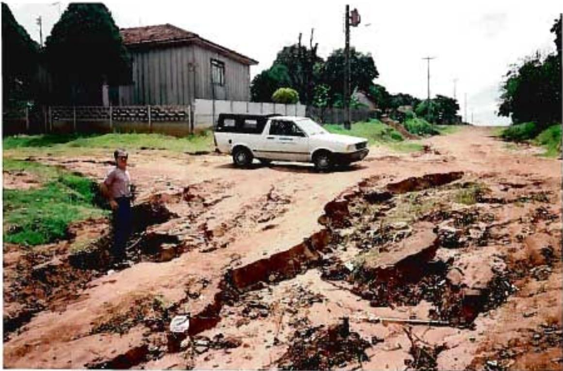
FOTO 2 - Sulcamento desenvolvido em ruas perpendiculares às curvas de nível em declividades superiores a 10%, no Jardim Cruzeiro.
