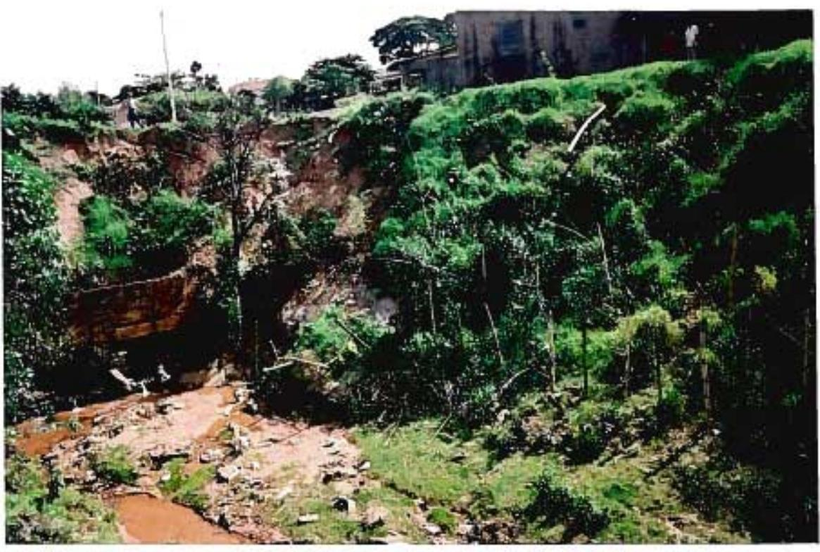
FOTO 5 - Boçoroca estabilizada. Note-se, porém, as cicatrizes de pequenos escorregamentos nas cabeceiras da galeria e o despejo de águas servidas no talude.
