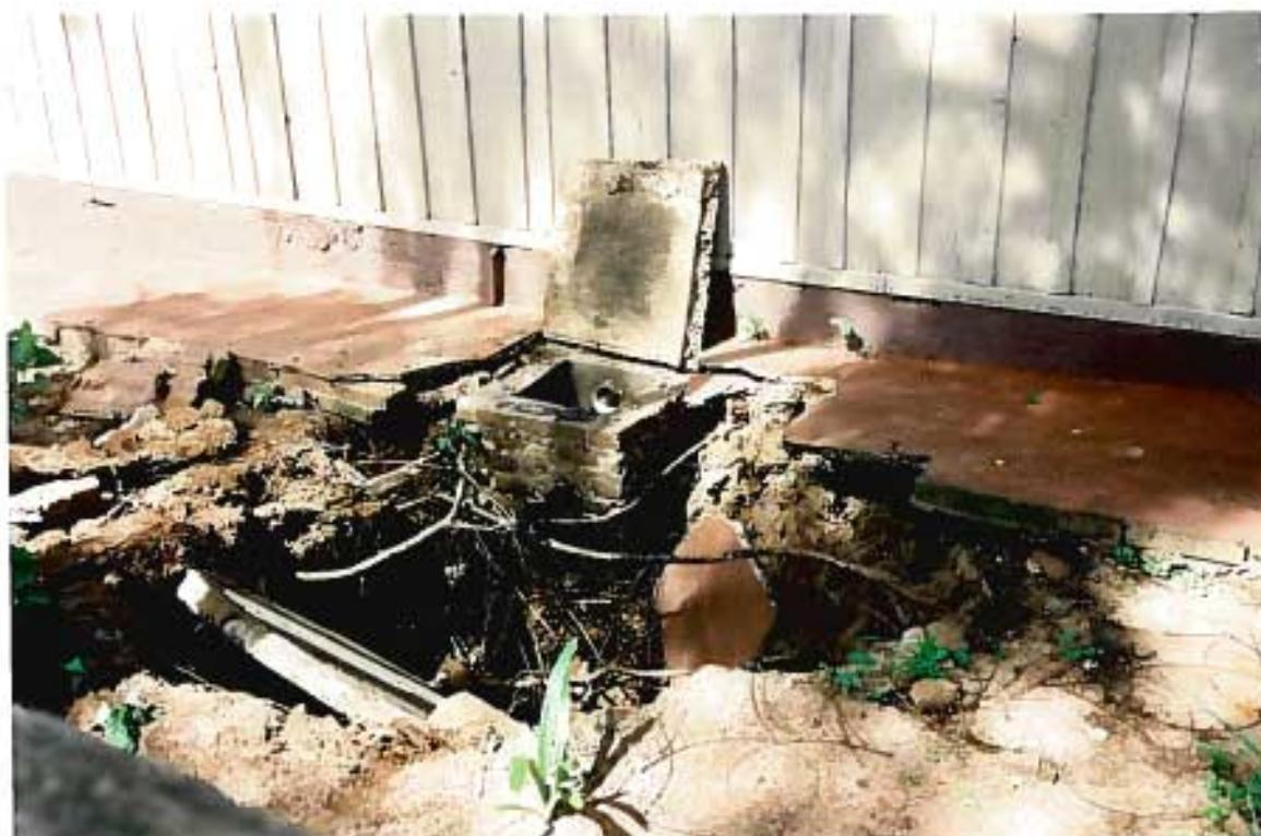
FOTO 8 - Colapso de fossa construída sem revestimento.
