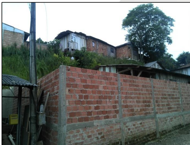
Fotografia 7. Habitações localizadas em áreas de alta vulnerabilidade a movimentos de massa (DSC00264).
