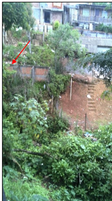
Fotografia 6: Muro de arrimo para conter movimentos de massa junto às ocupações. (seta vermelha) (DSC00256).
