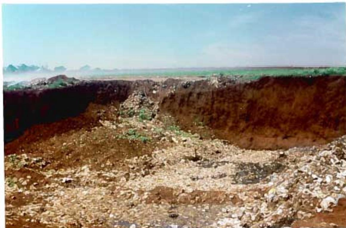
Foto 5: Aspecto do lixão de Assis Chateaubriand. Devido a falta de critério na deposição do lixo, ocorre à formação de chorume a céu aberto. Com a deposição em aterros sanitários, devido às técnicas utilizadas, este problema ambiental é sanado.
