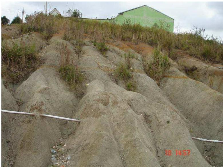
Figura 42 - Ravinamento profundo, passando à dimensão de boçoroca, expõe a tubulação. Notar a cobertura de solo remanescente, no topo do terreno.
