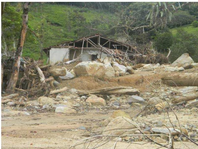
Figura 33 - Residência atingida pelos detritos provenientes da Serra do Mar na planície de deposição de sedimentos, em Floresta.
