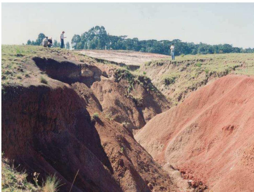
Figura 44 - Boçoroca com profundidade de mais de 4 m, em localidade próxima ao Supermercado Carrefour, município de Pinhais.
