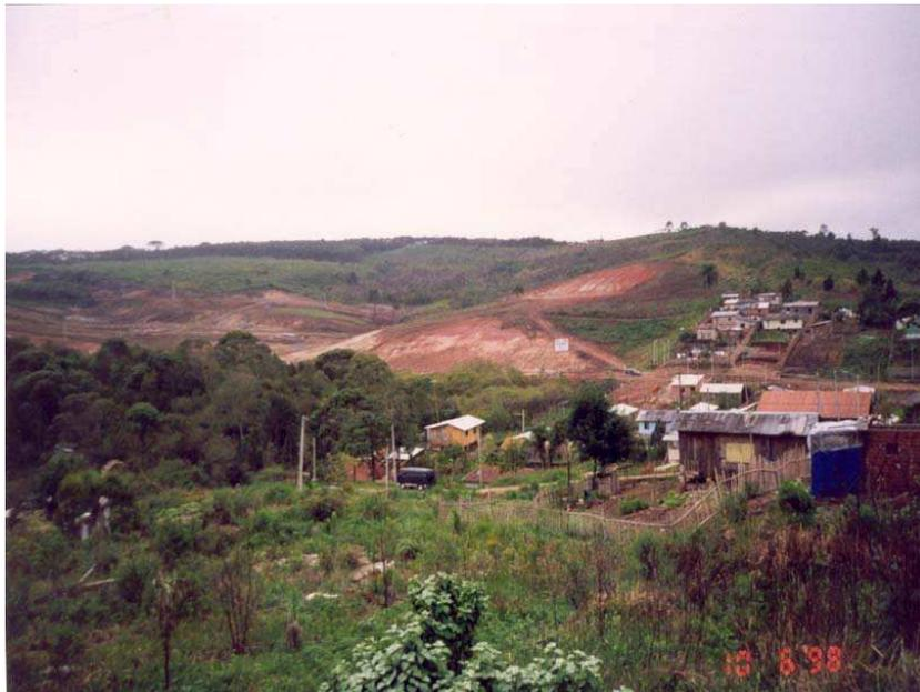
Figura 45 - Grande área decapada para a implantação do loteamento Santa Rosa, expondo a esmectita e iniciando o processo de erosão, em Campina Grande do Sul.
