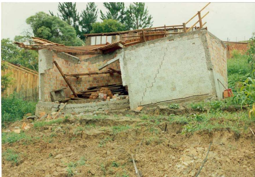
Figura 36 - Deslizamento em aterro, por liquefação da esmectita.
