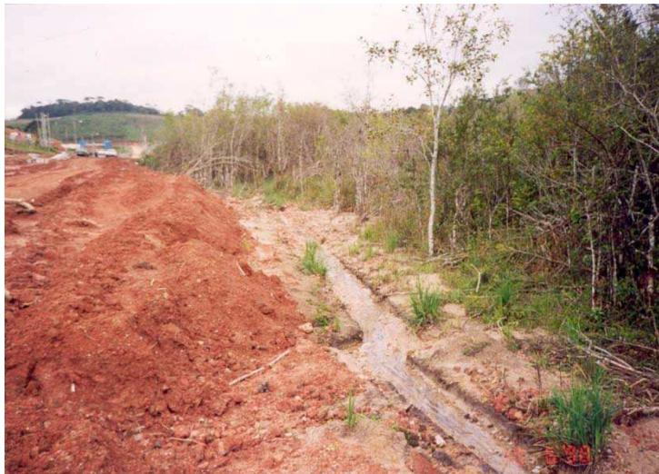
Figura 46 - Detalhe da foto anterior (Figura 44). Notar o alto grau de assoreamento da drenagem em consequência da implantação do loteamento Santa Rosa, em Campina Grande do Sul.
