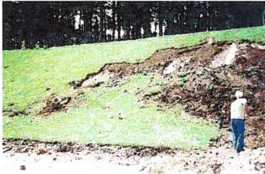
Foto 03 - Idem anterior, após várias tentativas de implantação da cobertura com gramíneas, mostrando a necessidade de taludes menos inclinados e drenagens para rebaixamento do nível freático.
