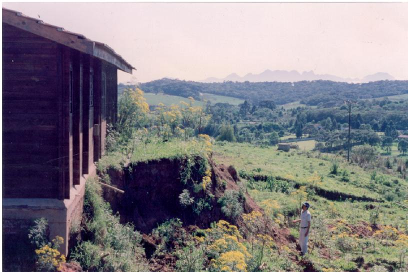
Figura 16 – Notar cicatrizes (falhas) do escorregamento rotacional em declividade  $> 20\%$ . Campina Grande do Sul/PR – 1993.
