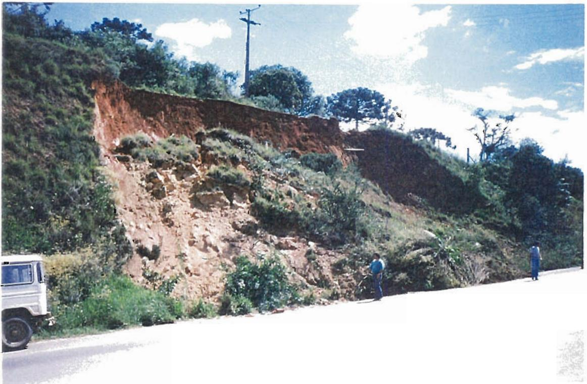
**Fotografia 17 - Folha A137, ponto OS-1152 - Deslizamento nos saprólitos de gnaisses-migmatitos na BR116, sentido Curitiba-Rio Negro.**
