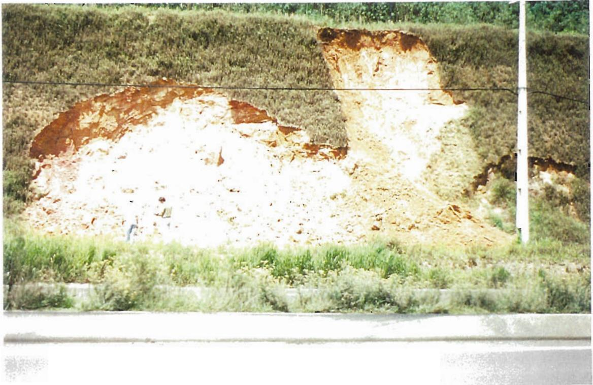
**Fotografia 16 - Folha A140, ponto LM-7332 - Deslizamento típico nos saprólitos de gnaiss-migmatitos quando o corte intercepta a foliação - BR-376.**
