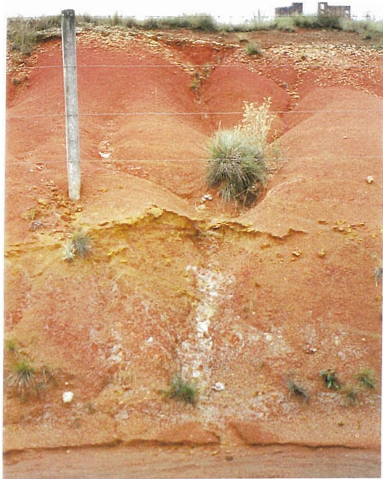
**Fotografia 20 - Folha A139, ponto RG-5058 - Erosão laminar com início de ravinamento no solo residual jovem (cor amarela), depois da retirada do solo residual maduro (cor vermelha). Formação Guabirota - São José dos Pinhais.**
