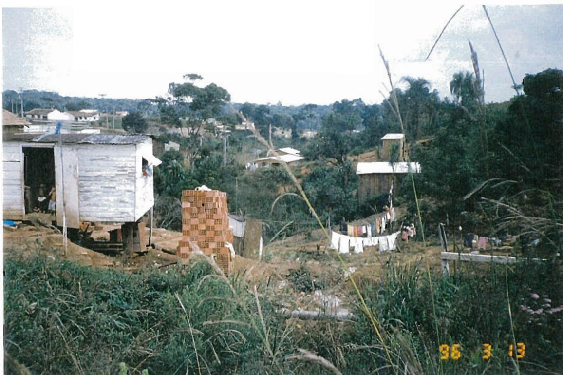
**Fotografia 26 - Folha A138, ponto SR-1868 - Loteamento Parque da Cascata, implantado sem critérios técnicos adequados em áreas de alta declividade e de cabeceiras de drenagem, causando erosão e assoreamento no vale.**
