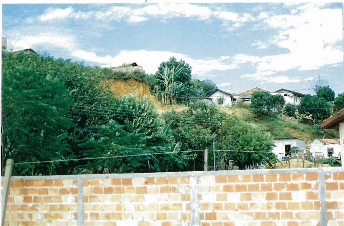
**Fotografia 27 - Folha A139, ponto RG-5150 - Loteamento em área de alta declividade sobre saprólito de gnaisses-migmatitos, sujeito a escorregamentos em função dos cortes executados - São José dos Pinhais.**
