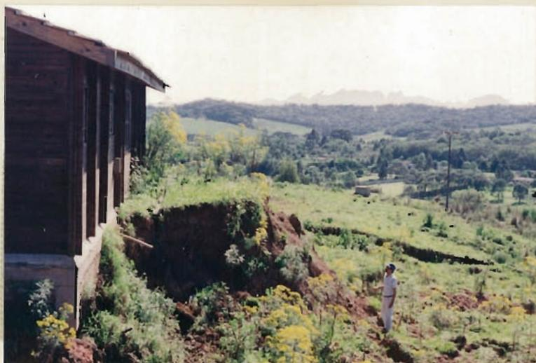
Fotografia 25 - Erosão e escorregamentos atingindo residências na região de Campina Grande do Sul, em área de sedimentos da Formação Guabirotuba.
