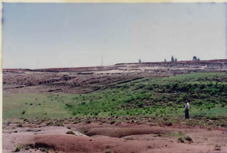
Fotografia 24 - Erosão de grandes proporções gerada pela remoção do solo como material de empréstimo, atingindo sedimentos da Formação Guabirotuba (OS-903).
