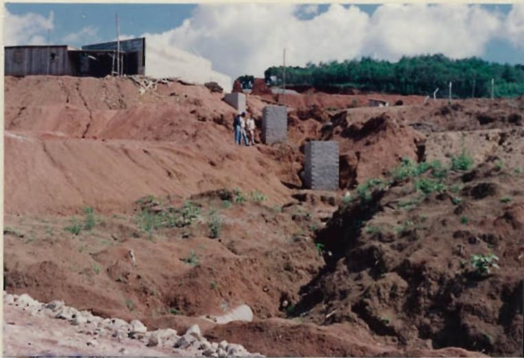
Fotografia 18 - Erosão de grandes proporções na unidade de argilas e arcósios da Formação Guabirota, junto ao Clube de Campo Santa Mônica (BR-116, OS-1013), devido a retirada do solo para material de empréstimo
