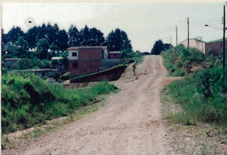
Fotografia 28 - Corte inadequado do terreno, expondo argilas erosivas, na região do Clube Santa Mônica - BR-116.
