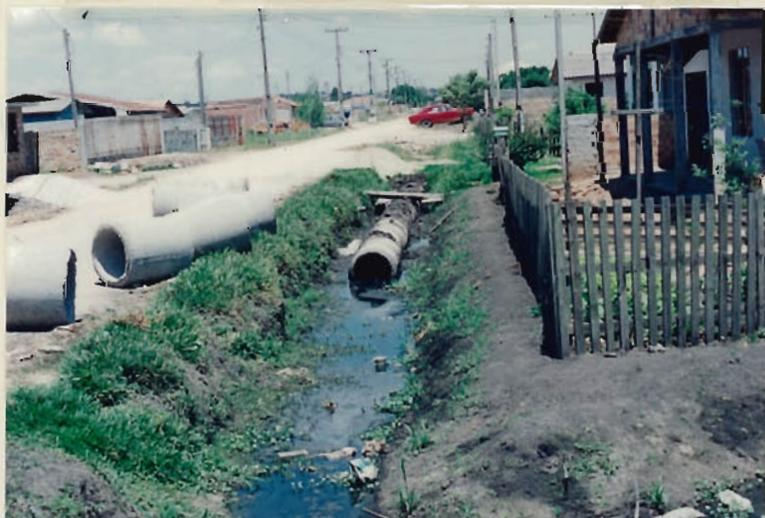
Fotografia 22 - Aspecto do problema de saneamento nas áreas aluvionares, no Município de Curitiba, Jardim Acrópole, mostrando a contaminação total do lençol freático. Proximidades da captação da SANEPAR no Rio Iguaçu.
