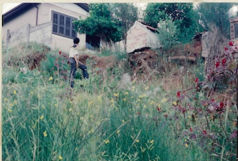
Fotografia 26 - Erosão e escorregamentos atingindo residências na área urbana de Curitiba.
