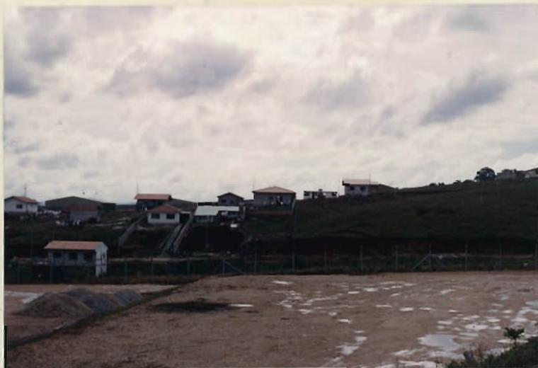
Fotografia 27 - Corte de encosta instabilizando o terreno em função da existência de sedimentos argilosos. Região a norte do trevo do Atuba, em direção a Colombo.
