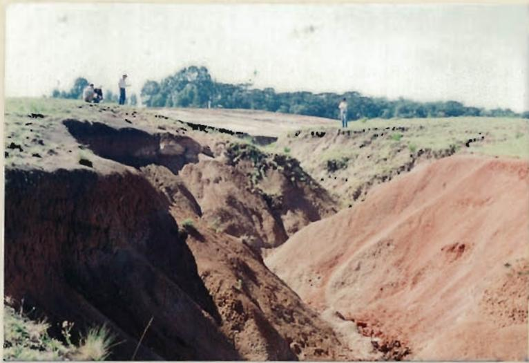
Fotografia 17 - Erosão causada pela exposição das argilas da Formação Guabirota devido a realização de terraplenagem (região de Campina Grande do Sul, OS-696).
