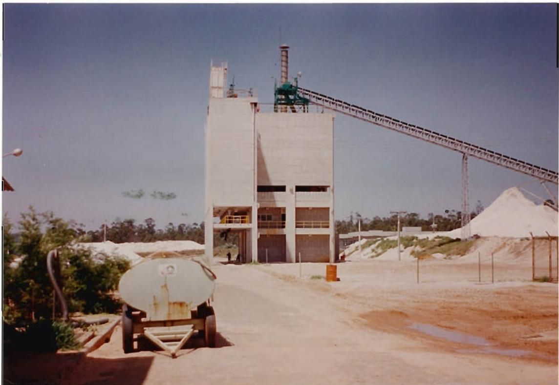
Foto 08: Prédio de secagem, com silos de armazenagem de areia seca.
