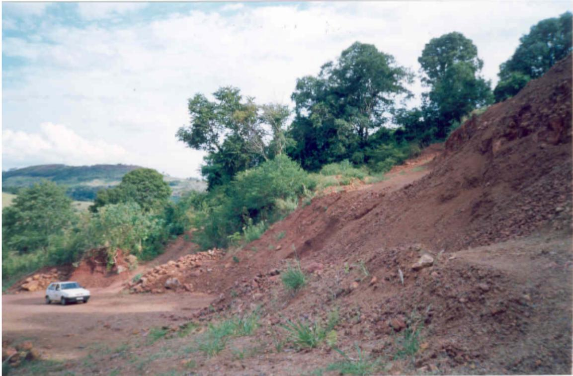
**Foto 5** Basalto fraturado, semi-alterado, fonte de saibro utilizado na conservação de estrada.
