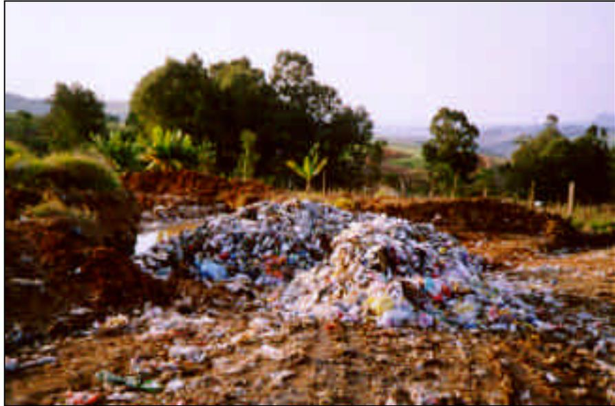
**Foto 5** : Ainda hoje o lixo sem nenhum tipo de seleção é amontoado e posteriormente recoberto por solo. A água superficial e o chorume não são captados, escoando para a drenagem local.
