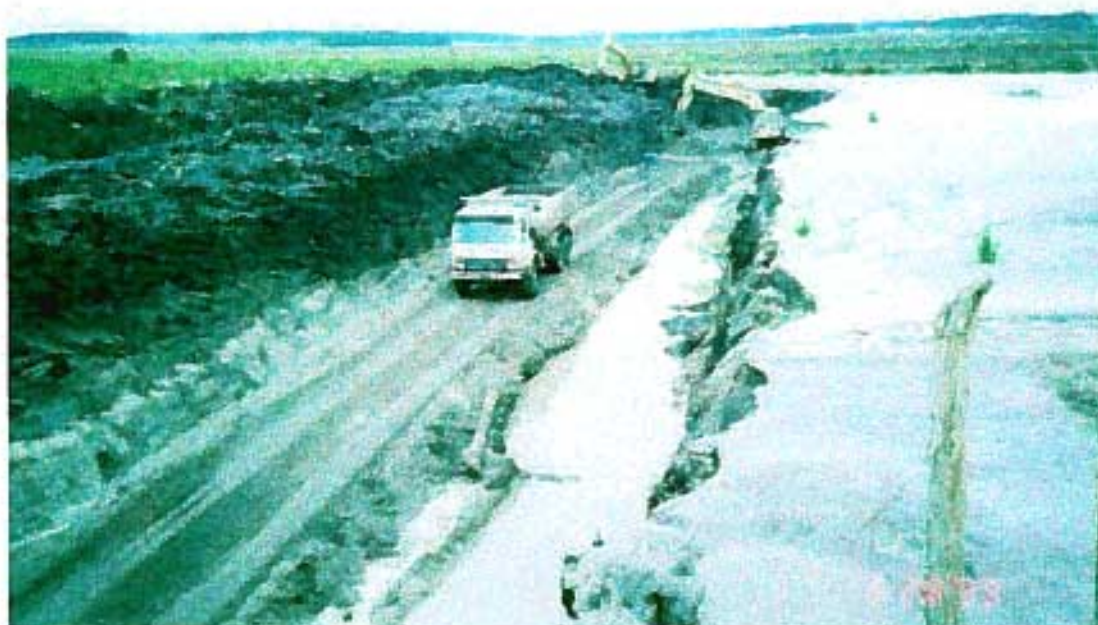
Retirada de areia e recuperação dos tanques de decantação (29 de maio de 1999)
