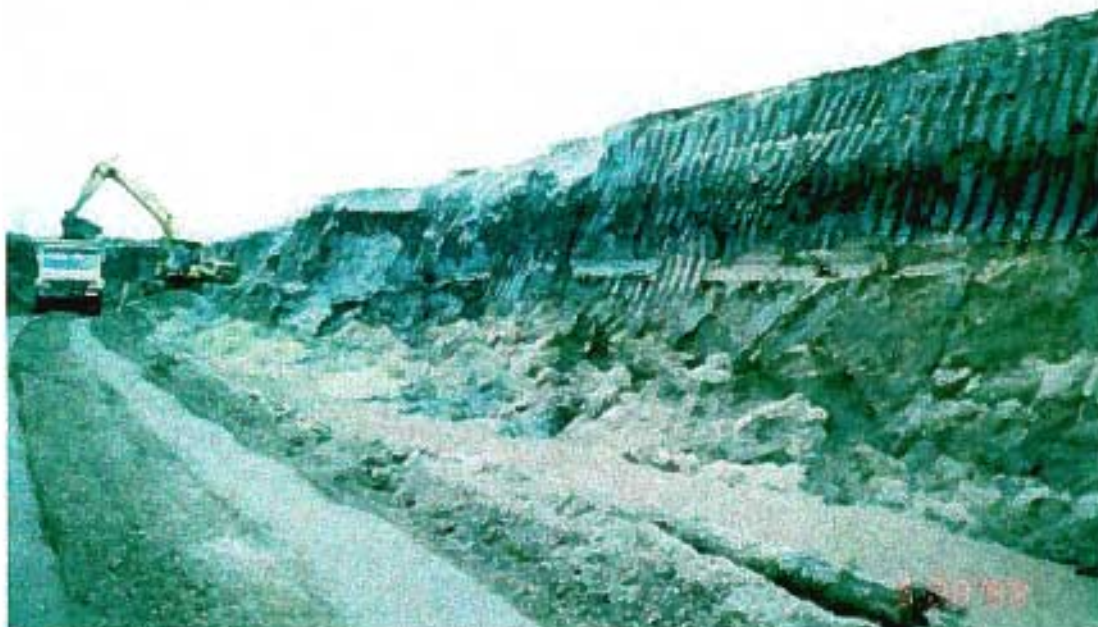
Retirada de areia para recuperação dos tanques de decantação (28 de maio de 1999)
