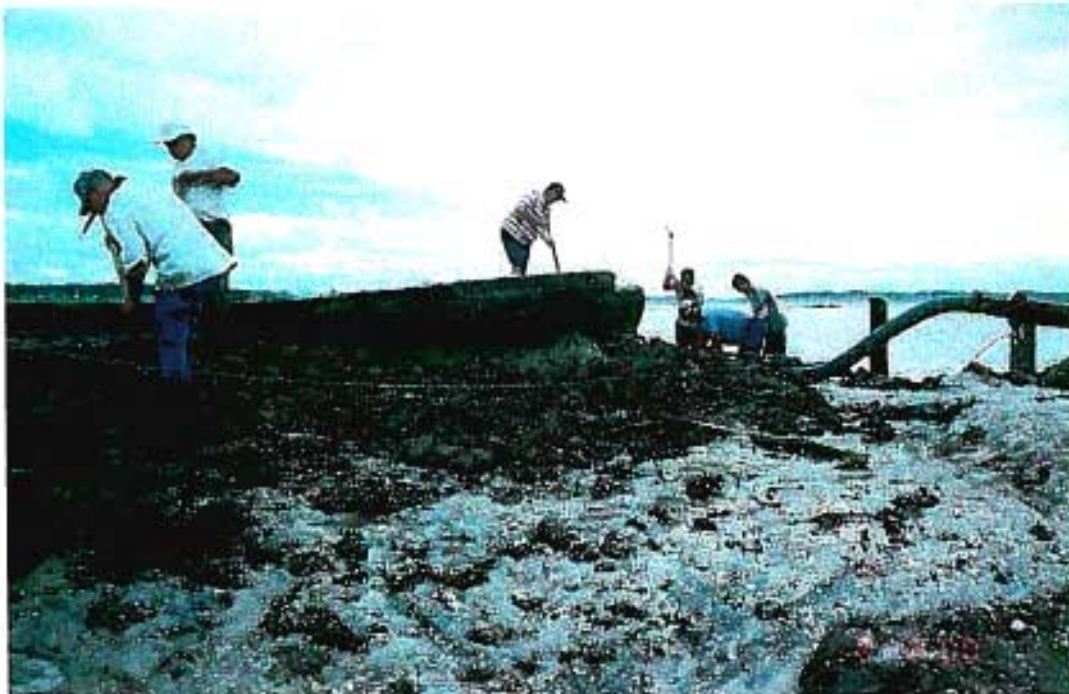
Vista da porção superior do material já desmontada (09 de fevereiro de 2000)
