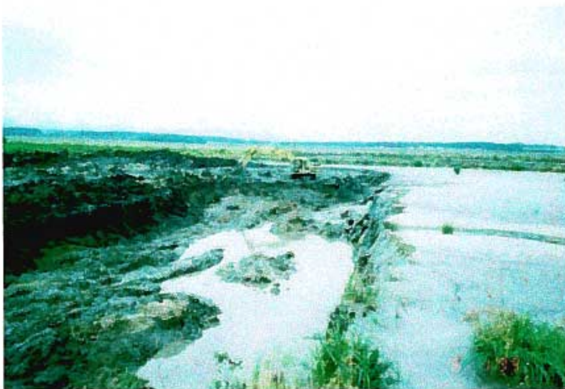
Recuperação dos tanques de decantação (01 de junho de 1999)
