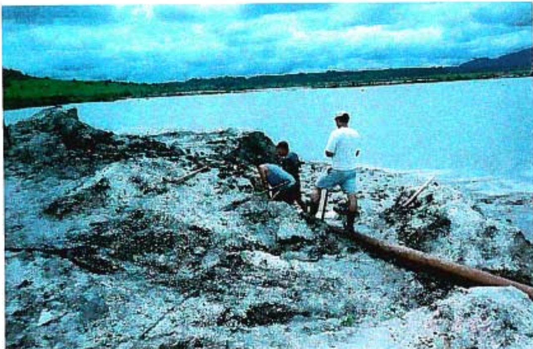
Material aflorante à lâmina d'água sendo desmontado (10 de fevereiro de 2000)
