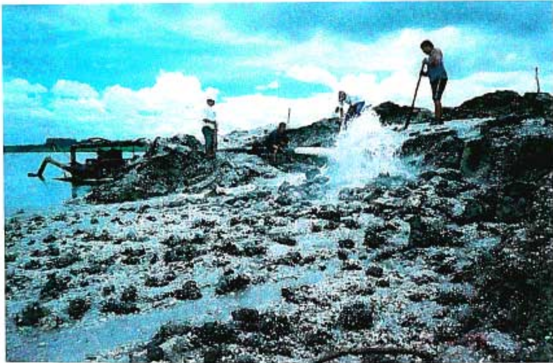
Vista do desmonte do material por jato d'água (10 de fevereiro de 2000)
