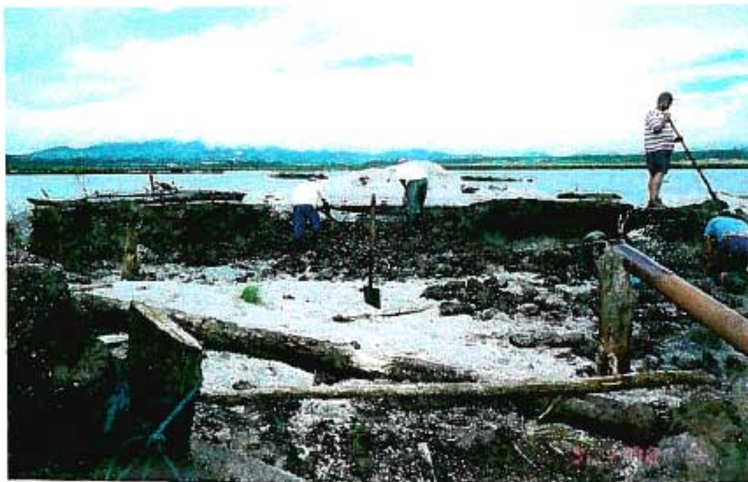
Retirada de madeira remanescente e material da porção superior (09 de fevereiro de 2000)
