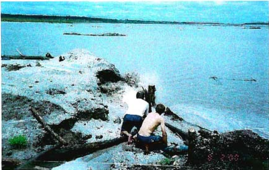
Vista do processo de desmonte do material por jato d'água (08 de fevereiro de 2000)
