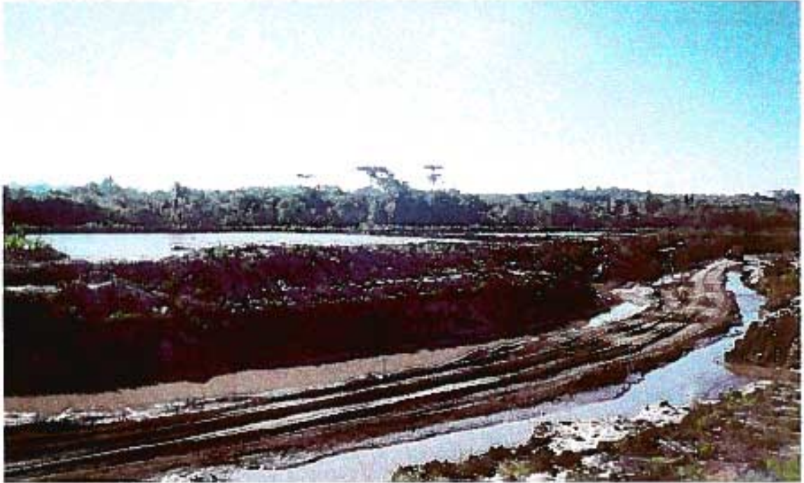
Acesso a área de lavra abaixo do nível topográfico e vista dos tanques de decantação
