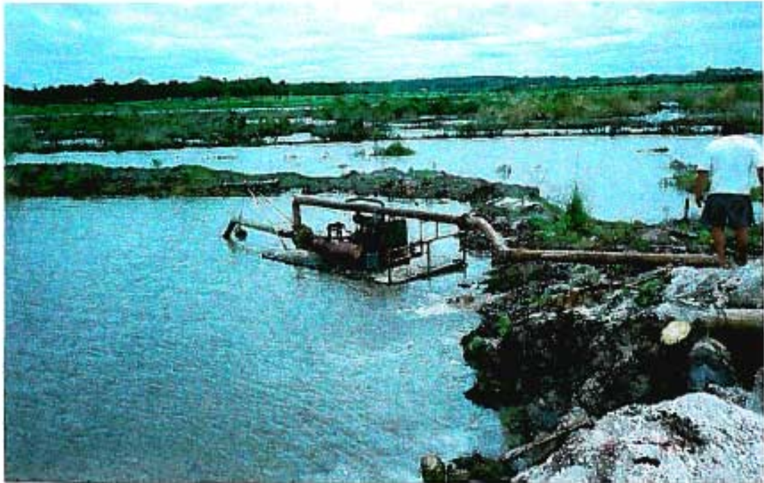
Draga utilizada para desmonte do material por jato d'água (08 de fevereiro de 2000)
