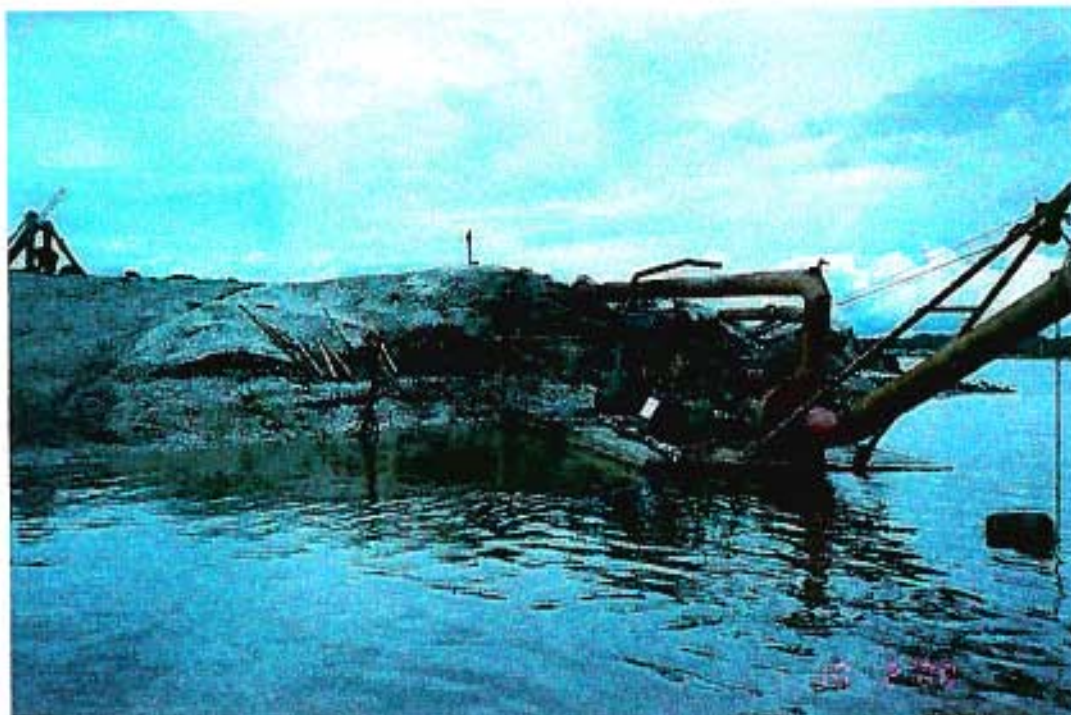
Draga utilizada no desmonte do material (10 de fevereiro de 2000)
