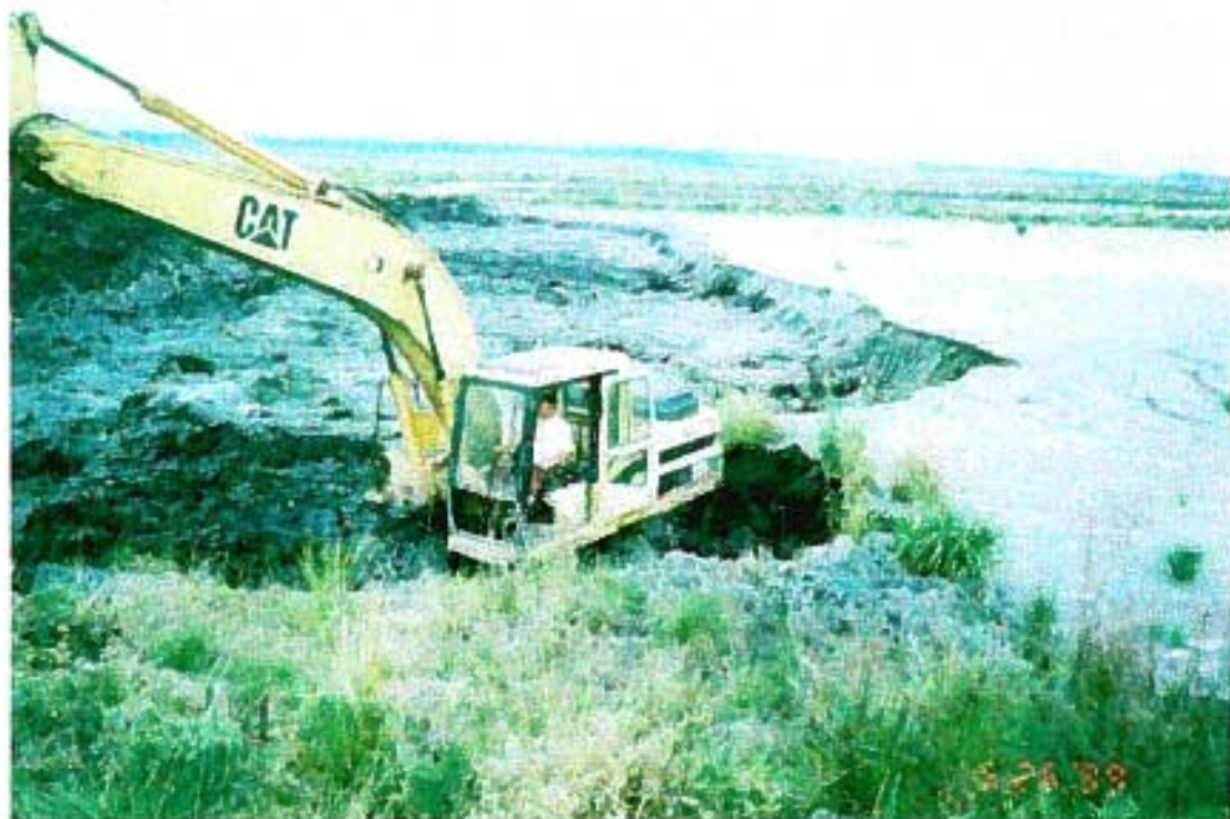
Recuperação dos tanques de decantação (26 de maio de 1999)
