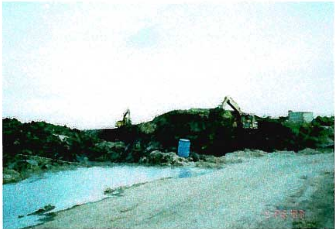
Recuperação da área de um dos lavadores (26 de maio de 1999)
