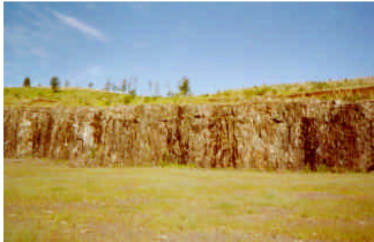
Foto 15. Paredão de rocha basáltica muito fraturada em grande pedreira paralisada, estrada para Teresa Breda (ponto BF-22).
