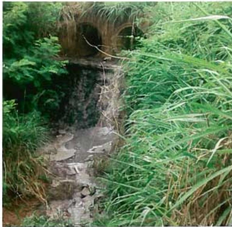
Foto 7 - Descarga de esgoto feita diretamente na drenagem. Fonte poluidora das águas superficiais e do meio ambiente.
