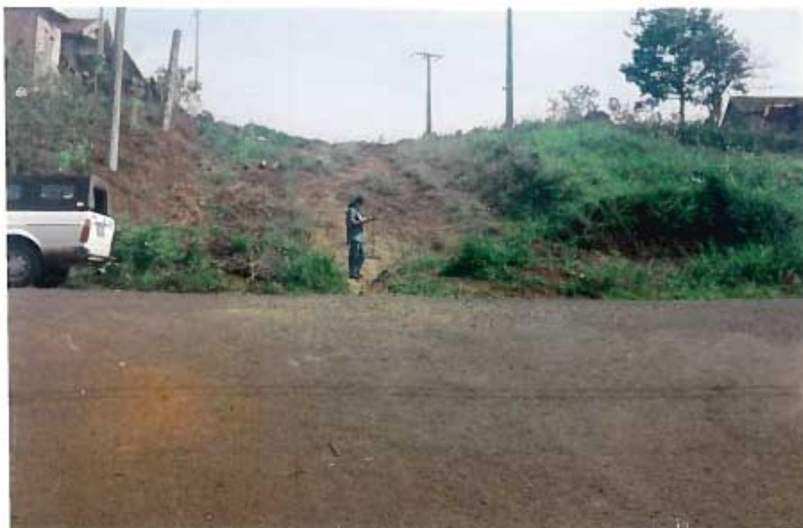
Foto 5 - Aspecto da desagregação mecânica em solos rasos. Este processo ocorre devido a abertura de ruas em locais com alta declividade, sem que sejam tomadas medidas técnicas.
