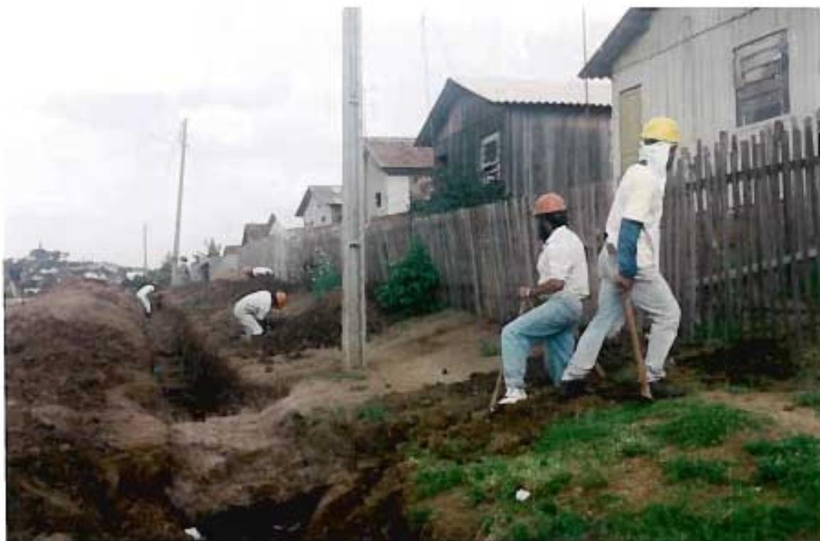
Foto 9 - Dificuldade na abertura de valetas para instalação de encanamentos , devido a ser área de solo raso com rocha aflorante.
