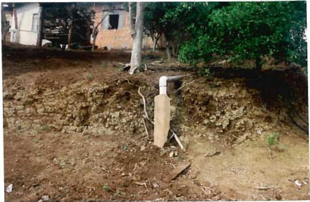
Foto 8 - Aspecto de encanamentos expostos em locais de solo raso sobreposto a rocha aflorante.
