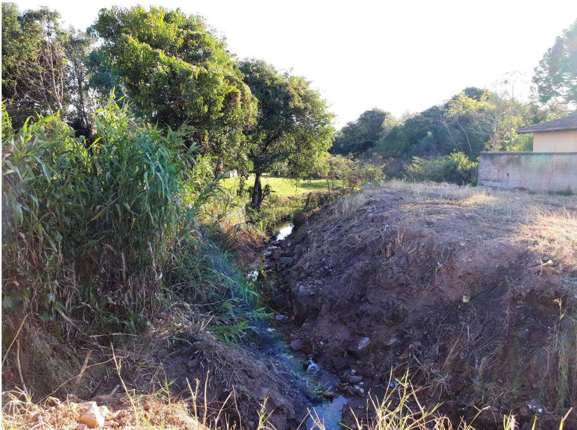
Foto 9 – Rua Leôncio Corrêa - além das casas ocuparem áreas de proteção ambiental, neste ponto, em particular, há um aterro que está assoreando a drenagem.
