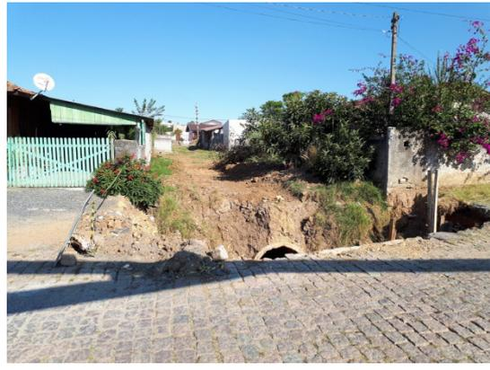
Foto 8a e 8b – O parque Linear Municipal termina na Rua Barão dos Campos Gerais. Neste local, a drenagem é canalizada entre as residências. Porém, o escape de água durante o período de chuvas mais fortes, causa erosão na base das manilhas.
