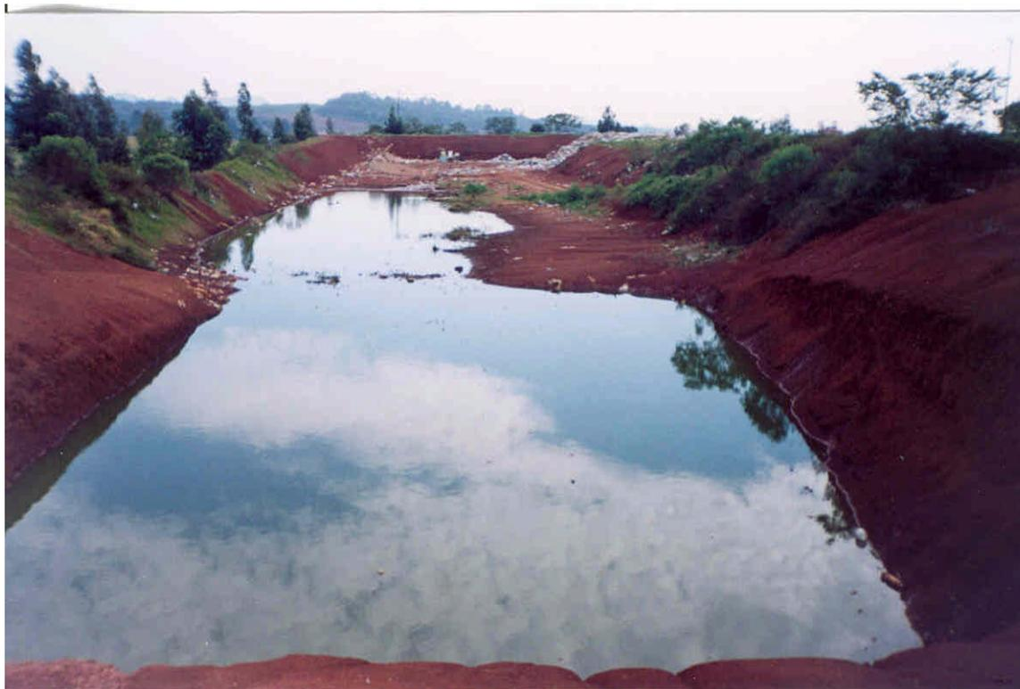
**Foto 33** – Vala aberta com inundação por água da chuva misturada com o chorume, contaminando o lençol freático (ponto LA-04)
