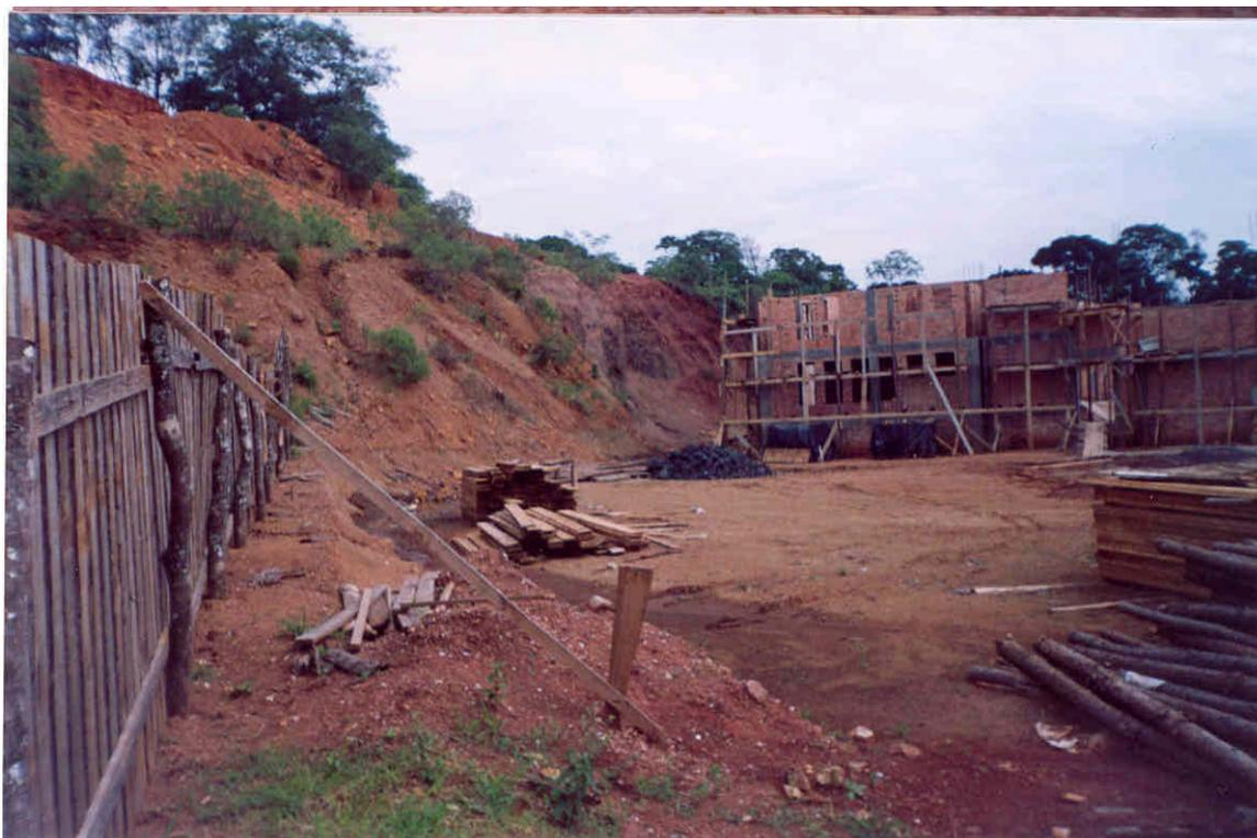
**Foto 24** – Detalhe do corte com perigo de escorregamento nos fundos do Centro Cultural em construção (ponto LA-10)
