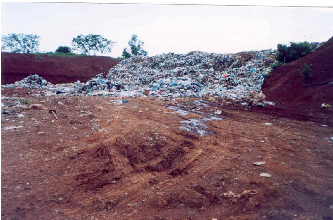
**Foto 32** – Detalhe da disposição do lixo sem critérios técnicos adequados, com evidente contaminação do solo e consequentemente das águas superficiais e subterrâneas (ponto LA-04)
