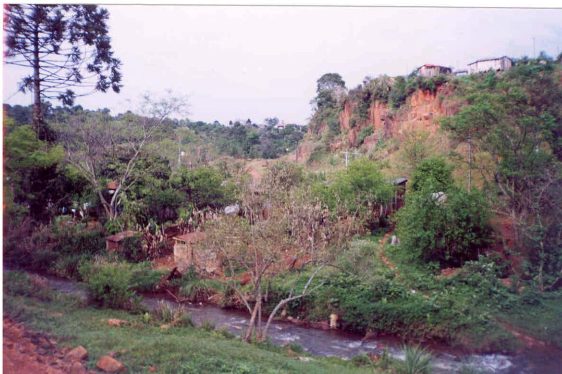
**Foto 19** – Ocupação irregular na área da antiga pedreira, com evidentes riscos geológicos e ambientais como queda de blocos e lançamento de esgotos na drenagem (ponto LA-07)
