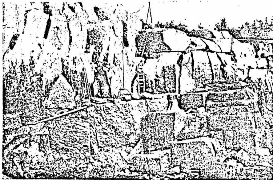
(Fig. 2) Granitos - Pedreira de Granito "La - brador oscuro" na Noruega. 95% do material ex traído é exportado. Tem uma densidade de 2.770 e uma resistência à compressão de 1.970 em frente.
