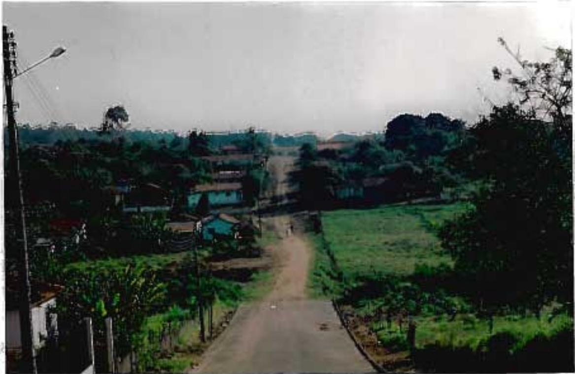
Foto 5 - Área de loteamento em terrenos com alta declividade, afetada por fenômeno de ravinamentos e sulcamentos no leito da rua.
