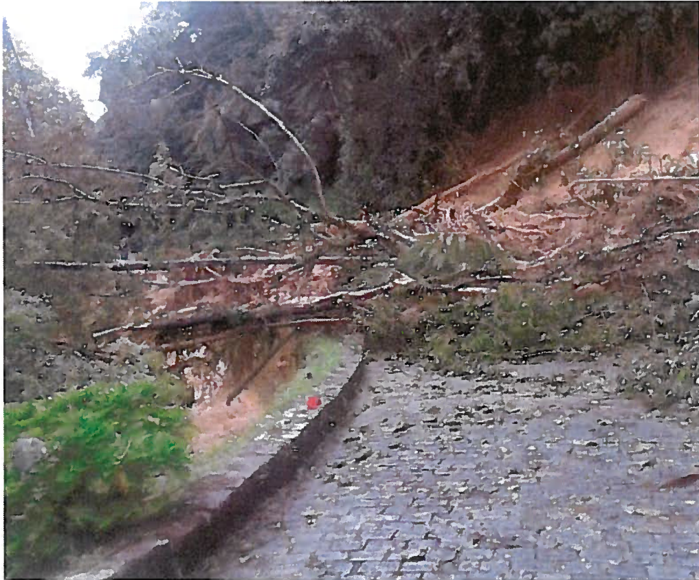
Figura 3. Local onde o material desmontado atingiu a estrada da Graciosa, cerca de 200 m abaixo da origem do deslizamento.
