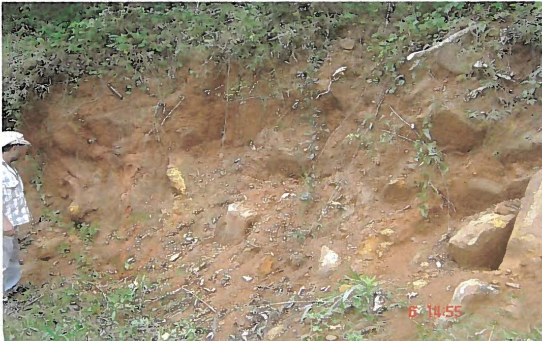
Foto 08 – ML 10 – Colônia 4 – Logo após o cemitério: grande afloramento com basalto alterado, alguns blocos alterados e muita massa argilosa, capaz de fixar as rochas sobre o leito da estrada.
