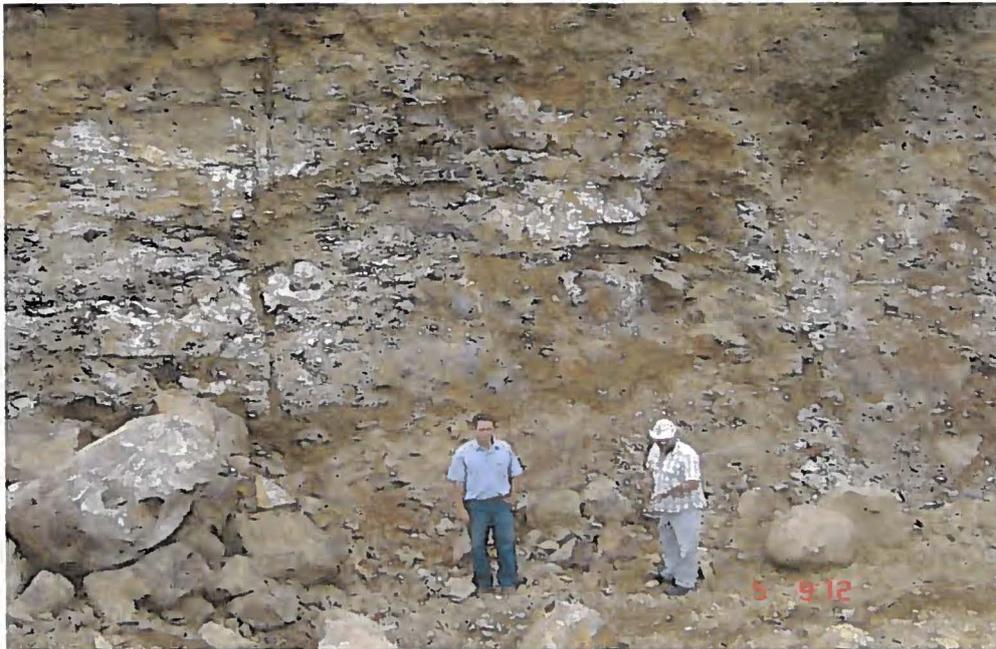
Foto 01 – Alto da serra, ML 01, limite com Cruz Machado/União da Vitória. Basalto alterado, facilmente desintegrado, muito bom para saibreira.
