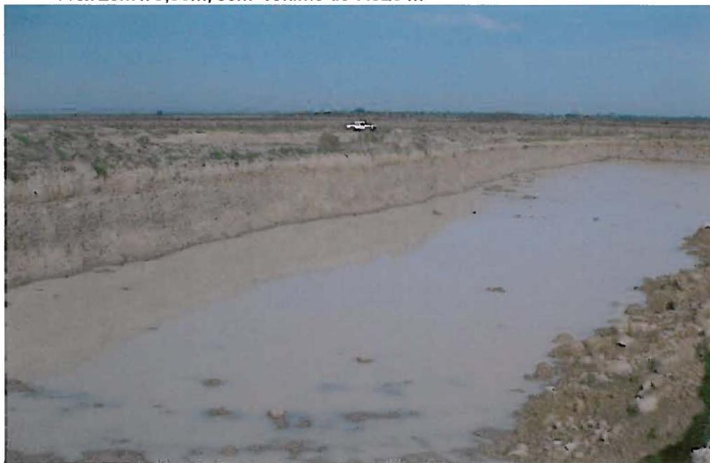
**Foto 05 – Outro aspecto da cava 01, observando a parede longitudinal e sua espessura composta praticamente de argila, menos 0,20 m superficiais, cobertos por gramíneas.**
