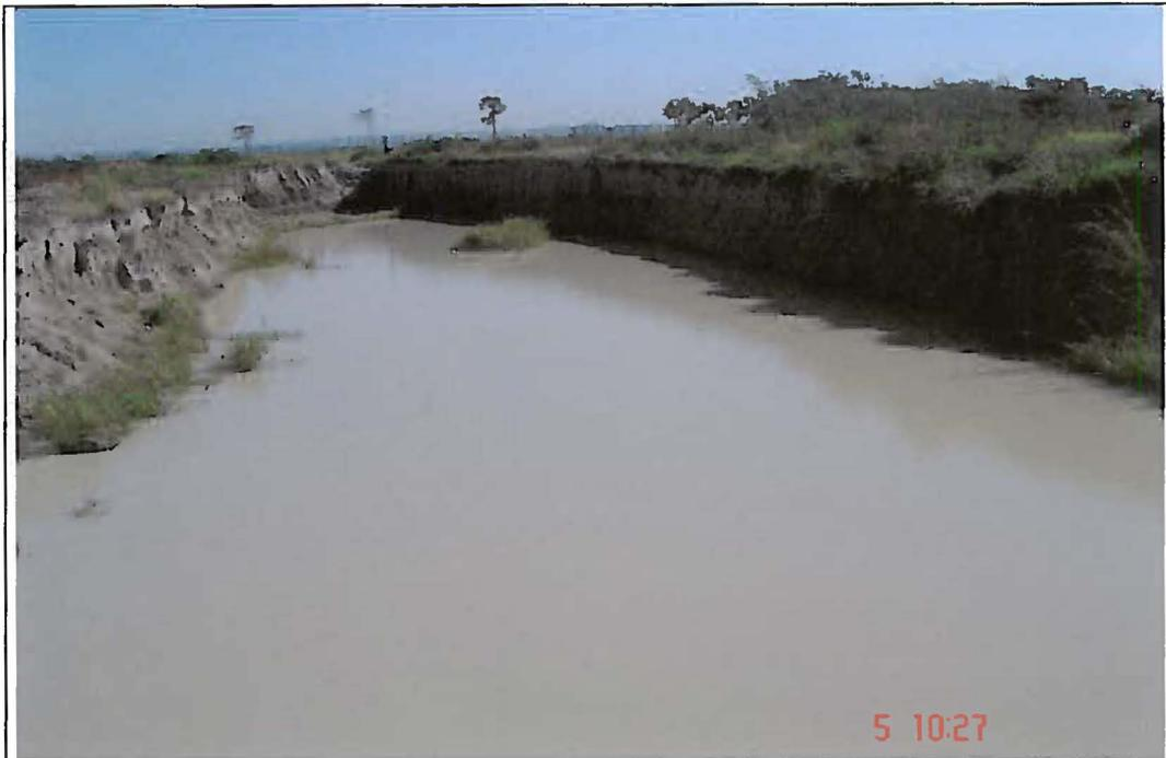
Foto-11 – Vista da cava 11, com 30x120 metros e de extensão e 3,40 m de profundidade, com volume de 12.240 m<sup>3</sup>. De sul para norte.
