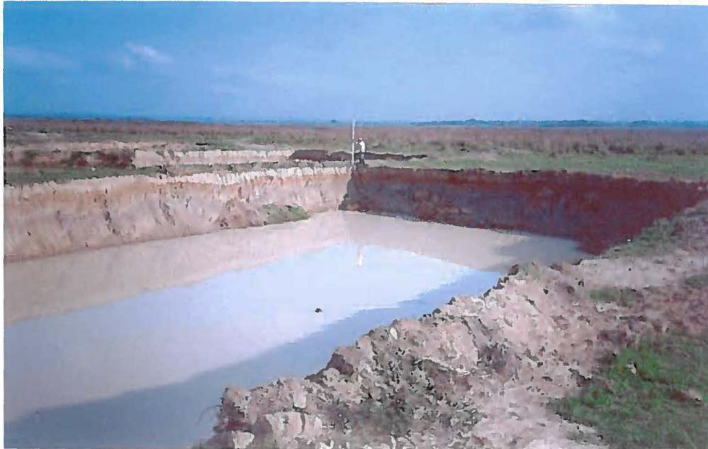
**Foto 02 – Vértice Norte da cava 2. Observa-se as paredes da cava, sua espessura e aspecto da argila.**
