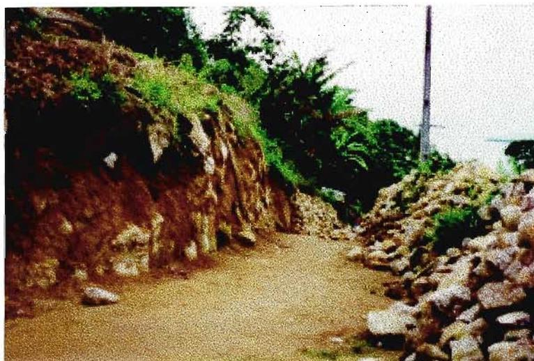
FOTO 10- SITUAÇÃO DE RISCO GEOLÓGICO EM ÁREA DE SOPÉ DE ENCOSTA, POTENCIALIZADA PELA ABERTURA DE TALUDES VERTICAIS SOBRE COLUVIOS, FAVORECENDO A INSTABILIDADE DO TERRENO(ESTRADA DO COSTÃO).
