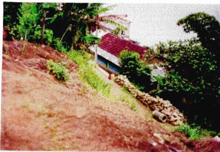
FOTO 13- ÁREA DE CAMBÍSSOLOS RECORTADOS PELA ESTRADA DO COSTÃO. A ALTA DECLIVIDADE FAVORECE A INSTALAÇÃO DE FENÔMENOS DE EROSIÃO E MOVIMENTOS DE MASSA (ESCORREGAMENTOS).
