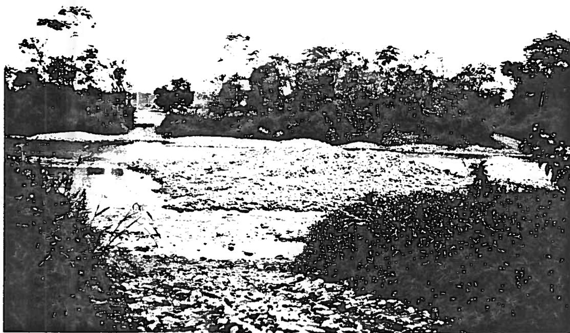
Foto 04 - Rio Nhundiaquara, Passo do Carvalho. Grande quantidade de cascalho depositado após a última cheia, concentrado neste local para a sua retirada.
