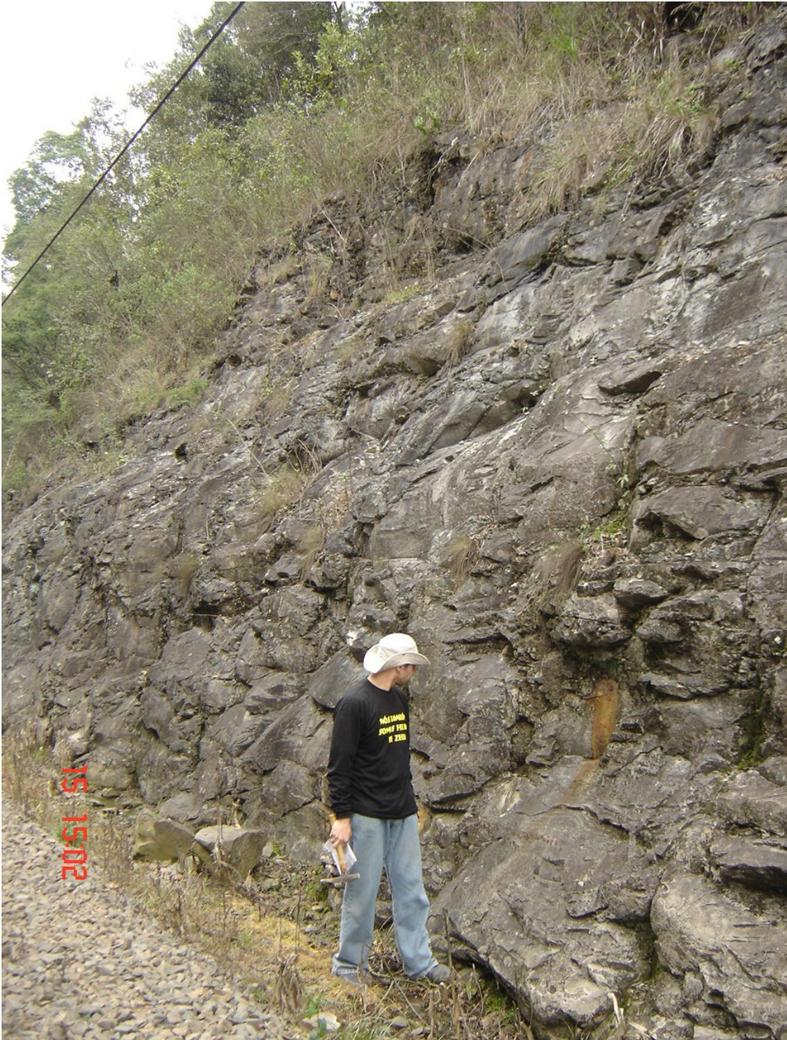
Foto 15 – IP 12 – Diamictito – Corte da estrada de ferro – Fundação Hildebrando. Corte de estrada mostrando diamictito inalterado, muito duro, com seixos de rochas diversas intercalados. Próprio para revestimento de estradas vicinais, porém necessitando de explosivo para detonar e britador para fazer a cominuição da rocha.
