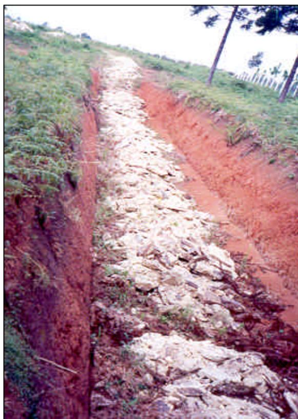
Foto 17. Vala do aterro sanitário de Palmeirinha com blocos de silito alterado.
