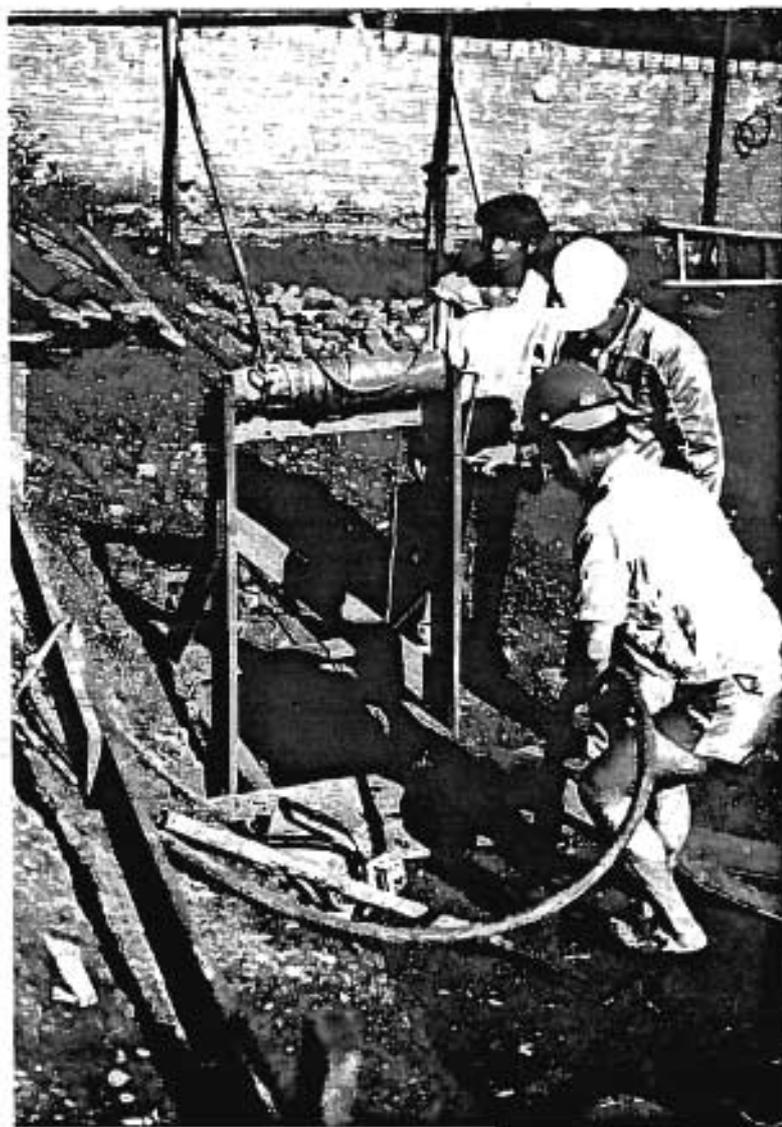
Foto 14 - Escavação em latossolo roxo, sem escoramento, na execução de fundação direta profunda.
