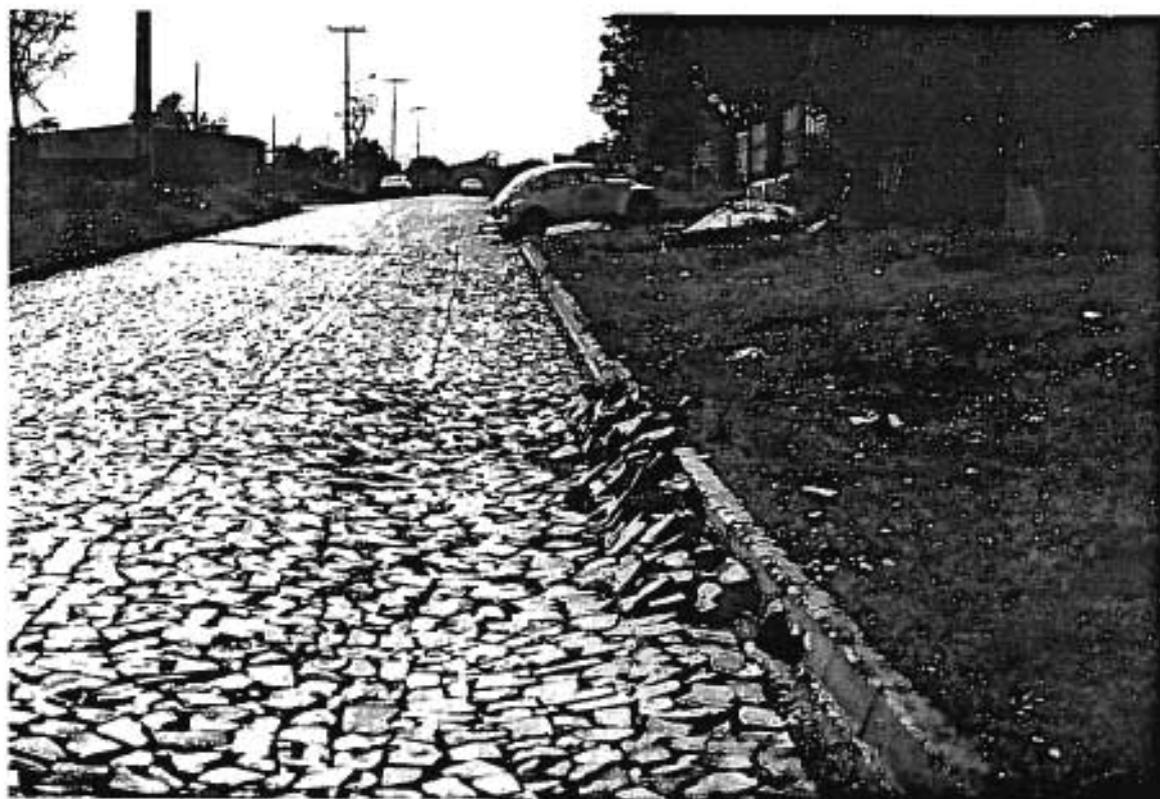
Foto 16 - Deformação do pavimento ("borrachudos") decorrentes da inadequada regularização do subleito.
