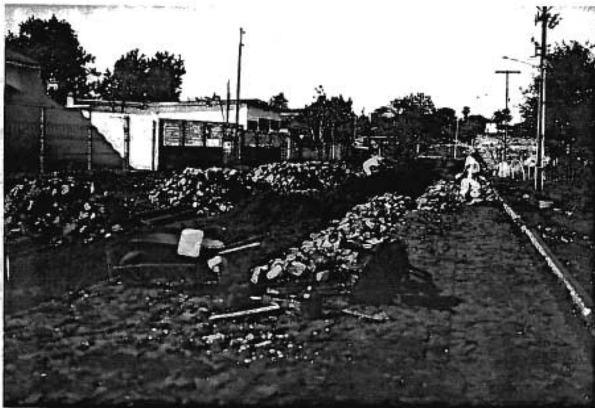
Foto 15 - Pavimentação de rua com alvenaria poliédrica (pedras irregulares).
