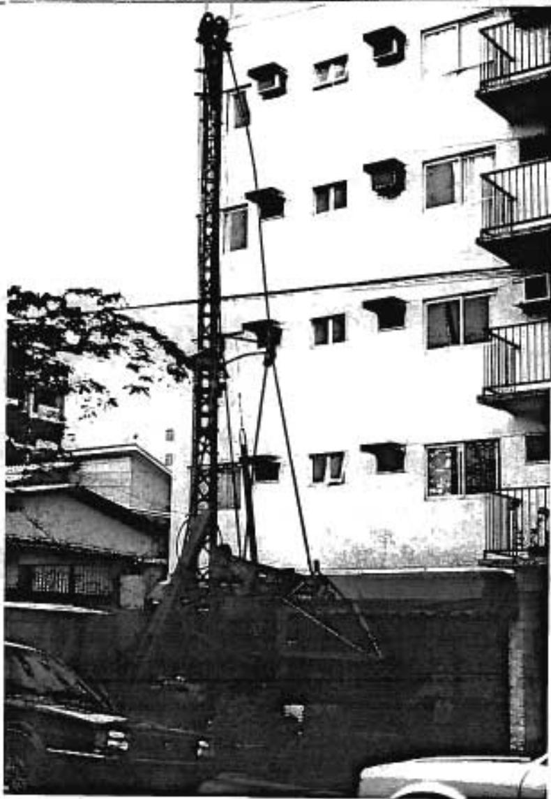
Foto 17 - Perfuração de poço tubular profundo para captação d'água no centro da cidade.
