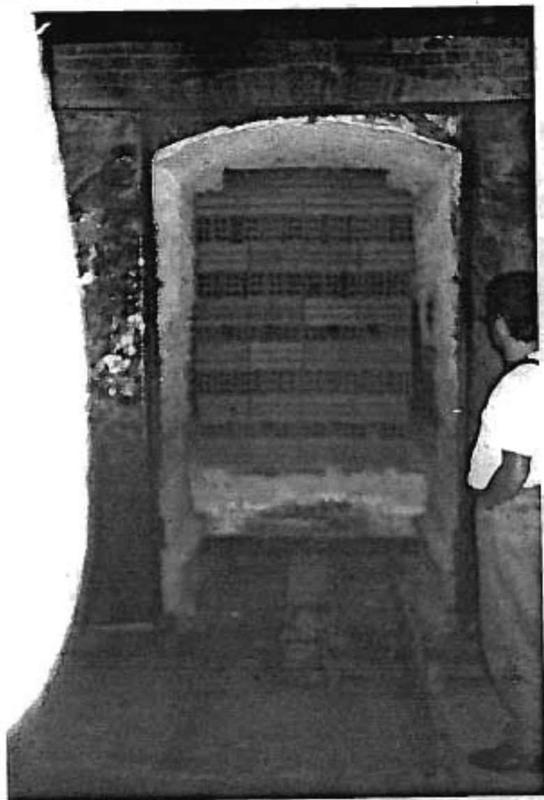
Foto 07 - Contraste tecnológico: processo de secagem em estufa aproveitando os vapores dos fornos.
