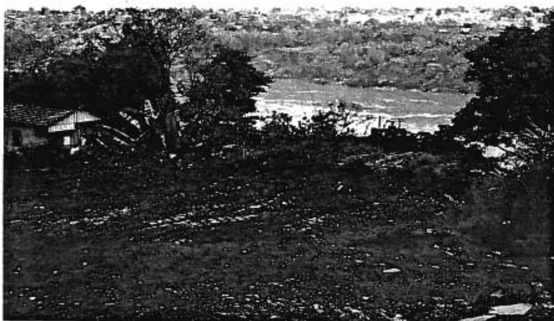
Foto 19 - Riscos de Escorregamento: Aterro em ponta de lâmina, avançando sobre o Rio Paraná, seguido de ocupação humana.
