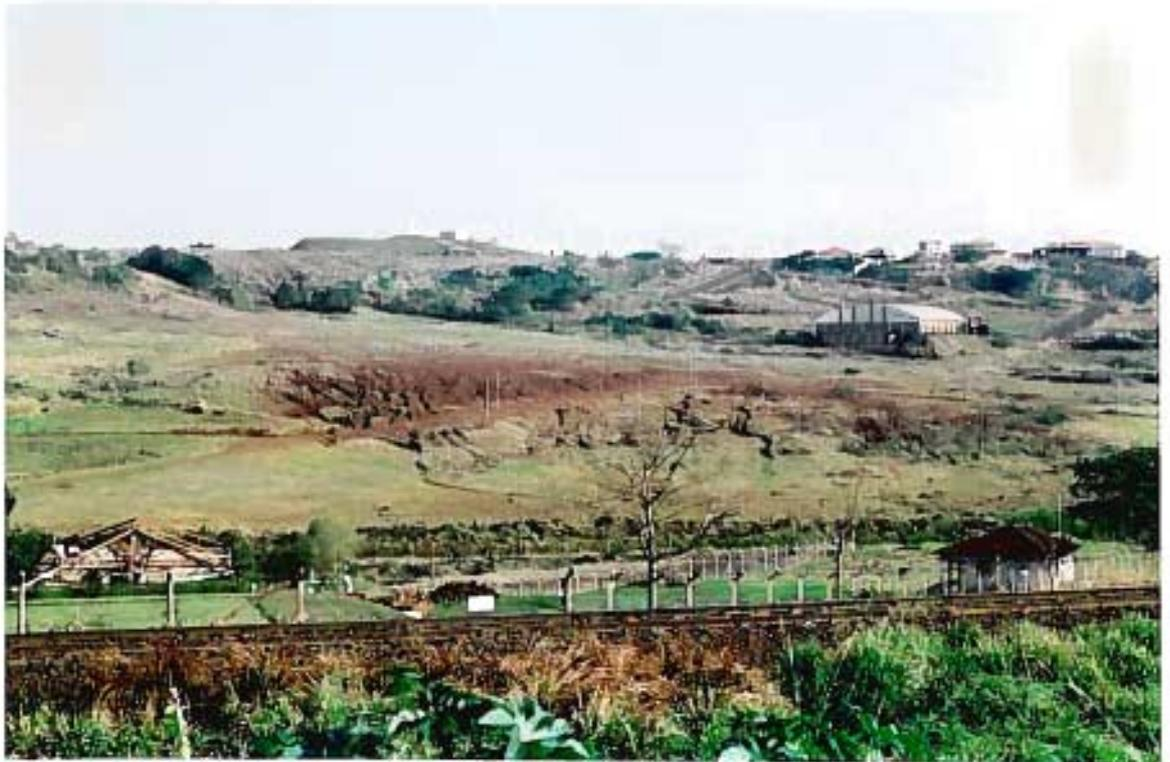
Foto 5 - Áreas com desenvolvimento de processos erosivos de ravinamento em loteamento implantado sem critérios técnicos adequados próximo ao ginásio de esportes em Cambará (PR).
