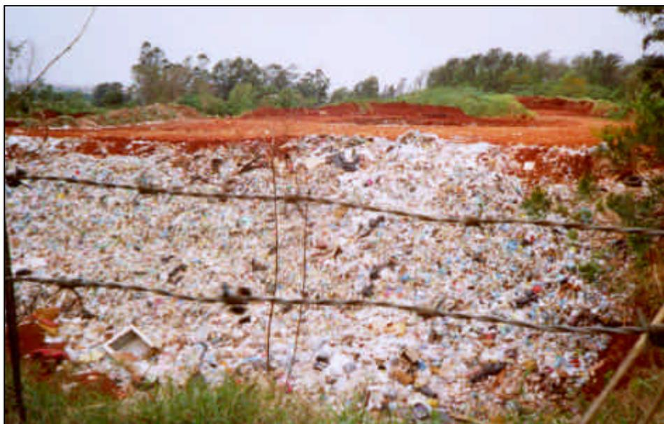
**Foto 25.** Vista frontal da frente de célula de lixo com implantação e manejo incorretos, contaminando o lençol freático e espalhando plásticos nas lavouras adjacentes (ponto MC-11).
