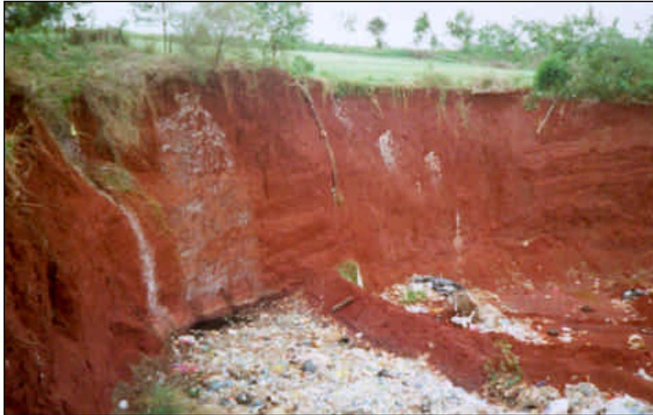
**Foto 23.** Grande escavação com deposição irregular de lixo doméstico, e descarte de líquidos provenientes de limpeza de fossas, em aterro sanitário com gestão deficiente (ponto MC-11).
