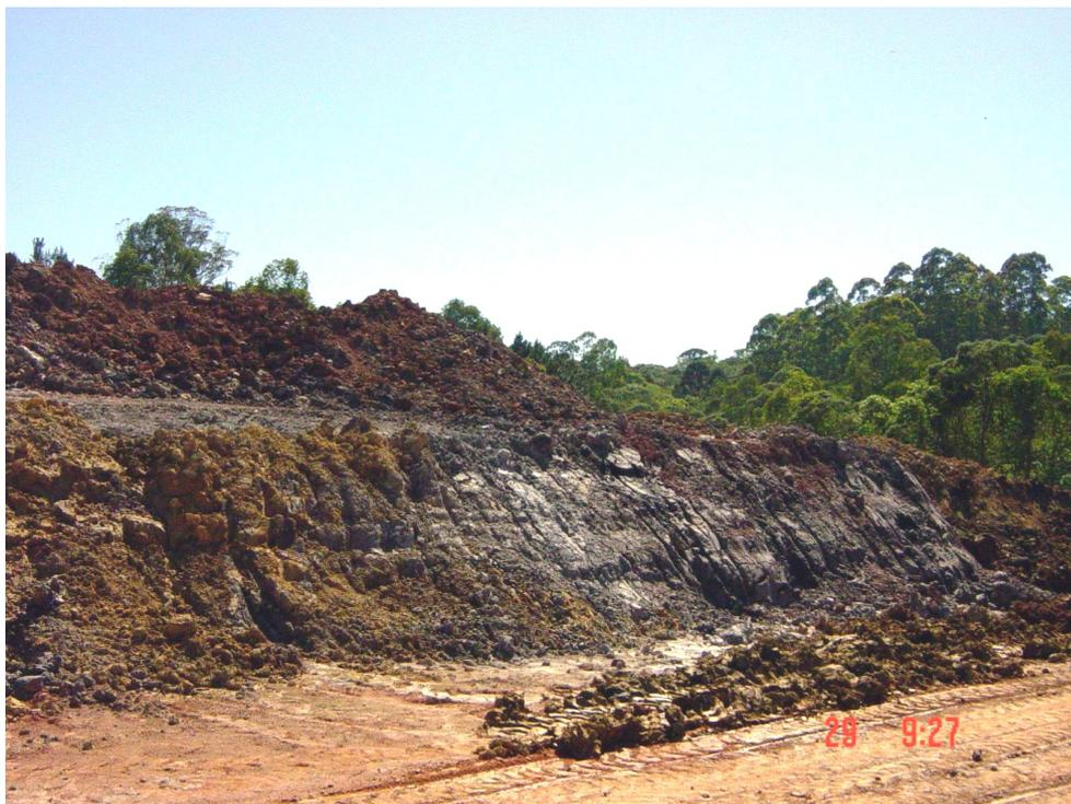
Foto 6: aspecto de uma pilha de estocagem onde foram misturadas as argilas de barranco e de várzea.
