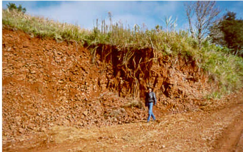
Foto 13. Cascalheira utilizada como fonte de material de empréstimo para a conservação de estradas, em Barracão.
