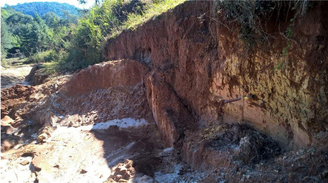
Foto 11: Afloramentos de pacote de arenito ao longo das estradas. Neste caso, com retirada de areia. EC LL-1252. Carta 2853-4, Pátio Velho.
